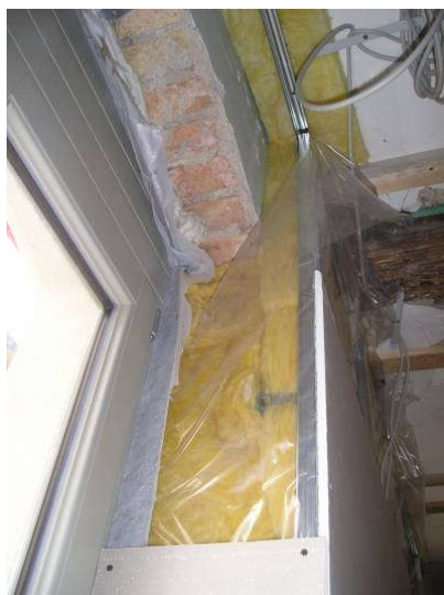
Rys 6. Przykład staranie wykonanej warstwy paroszczelnej i szczelnego połączenia z oknem zewnętrznym
