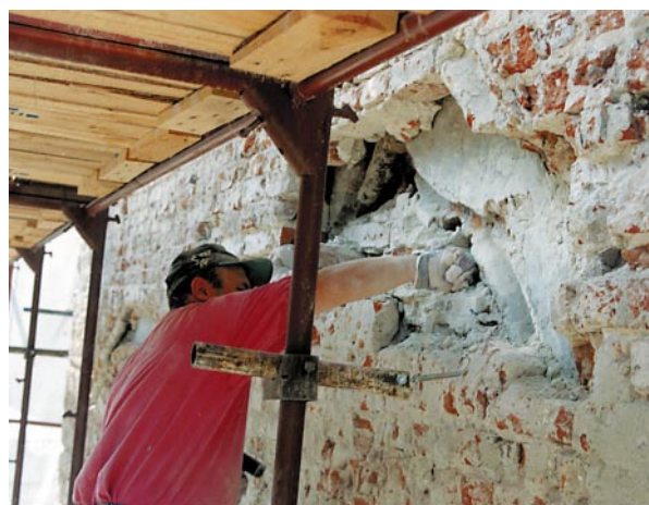
Olsztyn, Stary Ratusz, elewacja wschodnia w trakcie odsłonięcia portalu. Stan z sierpnia 2002 r. Fot. W. Chodkowska
