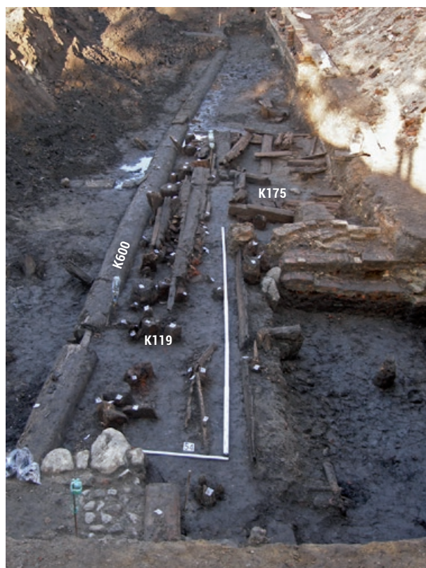
Ryc. 65. Gdańsk, Podwale Przedmiejskie, stan. 29, badania 2011–2012, wykop 2. Wodociąg, konstrukcja K 600, widok od W. Fot. J. Ludyga
