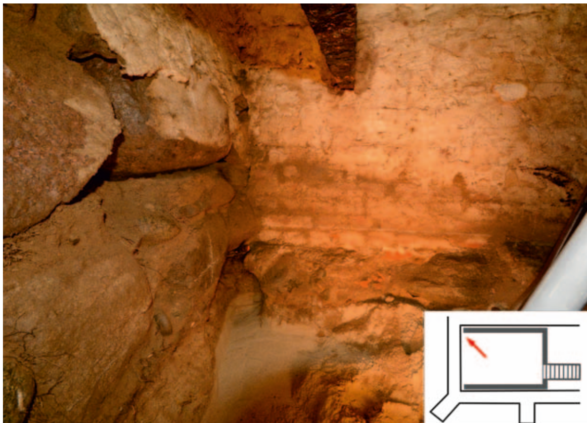
Ryc. I.15. Widok północno-zachodniego narożnika krypty Wejherów z dostawioną północną ścianą komory grobowej do gotyckiego fundamentu nawy. Fot. M. Miścicki.
