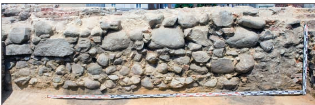
Ryc. 75. Zielona Góra, stan.31, woj. lubuskie. Wykop 6, lico południowe fundamentu muru cmentarnego. Fot. B. Gruszka
