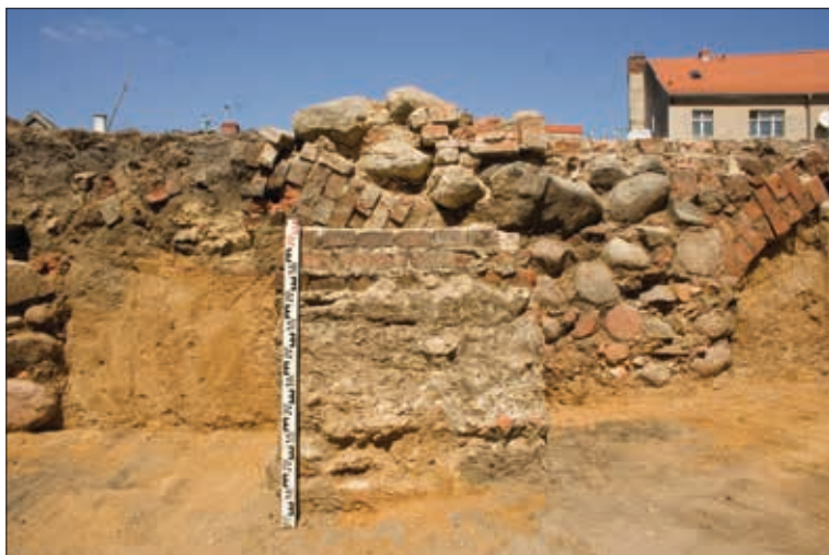
Ryc. 77. Zielona Góra, stan.31, woj. lubuskie. Wykop 1C, lico południowe fundamentu przypory. Fot. B. Gruszka
