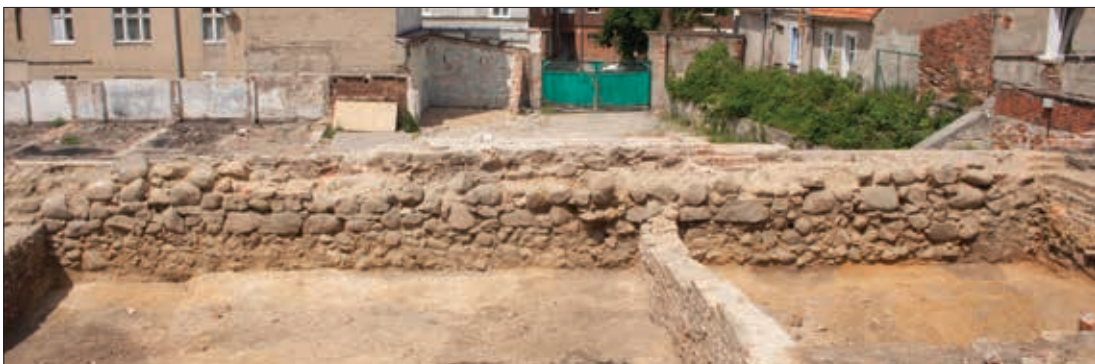
Ryc. 1. Zielona Góra, stan.31, woj. lubuskie. Wykop 5 i 6. Widok ogólny od południa relikty kamiennego muru fundamentowego. Fot. B. Gruszka
