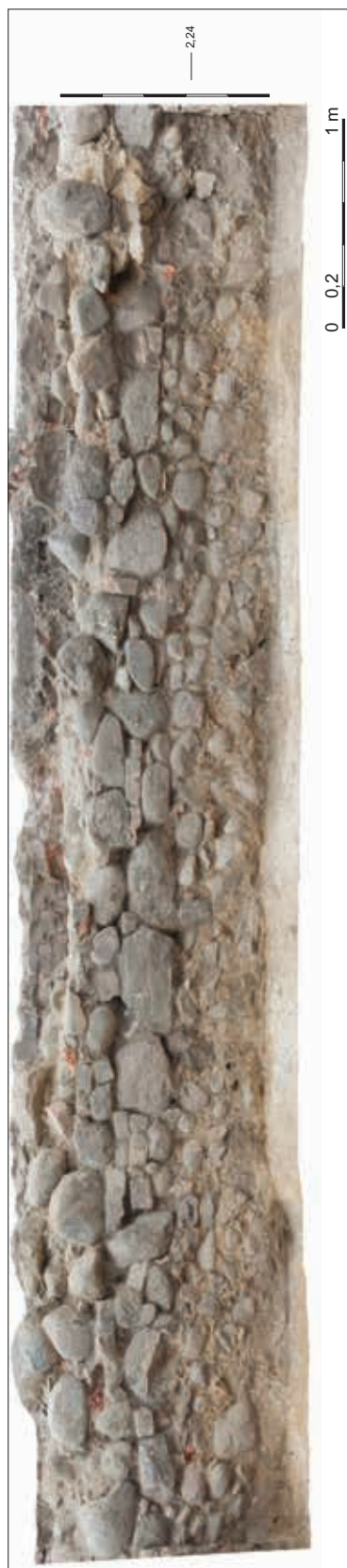
Ryc. 76. Zielona Góra, stan.31, woj. lubuskie. Wykop 5, fotogrametria południowego lica fundamentu muru cmentarnego. Fot. B. Gruszka
