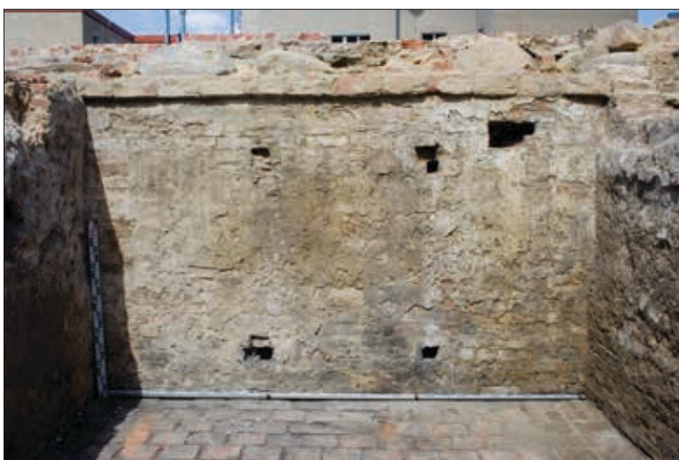
Ryc. 86. Zielona Góra, stan.31, woj. lubuskie. Wykop 3, pomieszczenie piwniczne, lico ściany północnej. Fot. S. Kałagate
