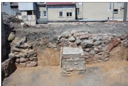
Ryc. 3. Zielona Góra, stan.31, woj. lubuskie. Wykop 1. Widok ogólny od południa na relikty muru o konstrukcji filarowo-łękowej z kamiennymi filarami i ceglanyimi łękami. Fot. B. Gruszka
