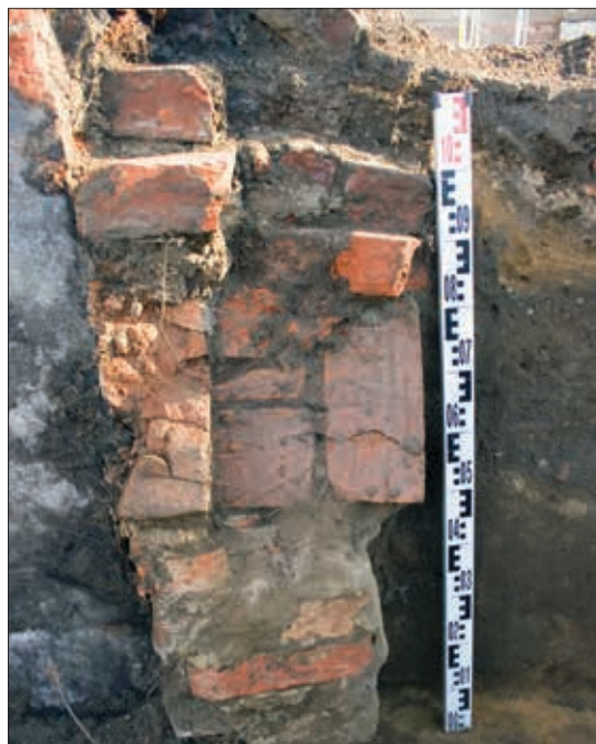
Ryc. 24. Zielona Góra, stan.30, woj. lubuskie. Sondaż 7, pozostałości ceglanego łuku muru cmentarnego. Fot. S. Kałagate
