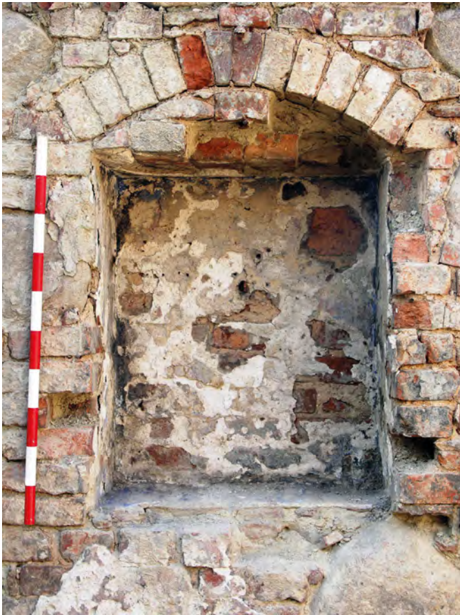
Ryc. 15. Stargard, Stare Miasto, kwartał IX. Nisza w ścianie W piwnicy tylnego traktu kamienicy Targ Drzewny 19. Fot. M. Majewski Abb. 15. Stargard, Altstadt, Quartier IX. Nische in der Westwand des Kellers im Hintertrakt des Bürgerhauses in der ehemaligen Holzmarktstraße 19. Foto M. Majewski
