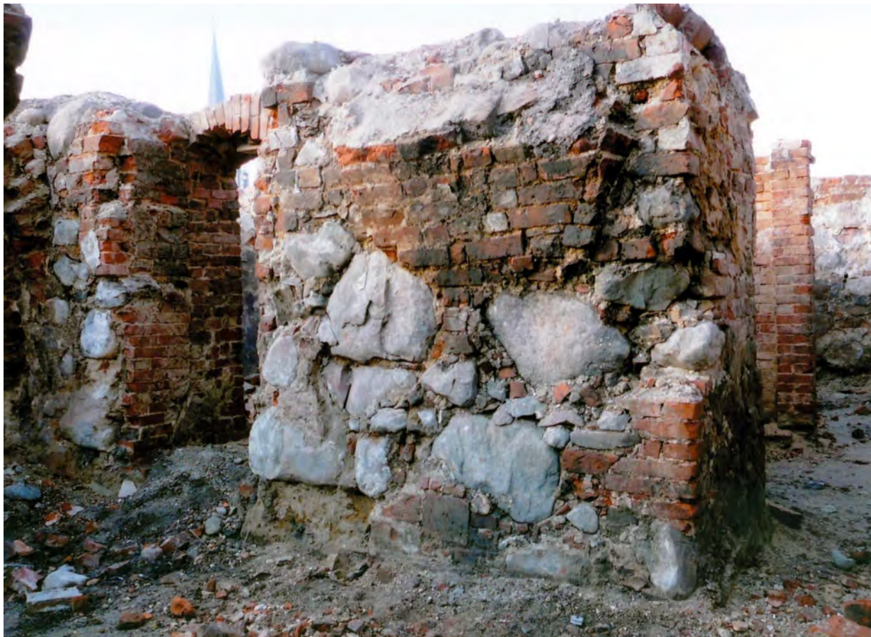
Ryc. 10. Stargard, Stare Miasto, kwartał IX. Zejście od dawnej ul. Wielkomłyńskiej do narożnej piwnicy kamienicy Targ Drzewny 19. Widok od W. Fot. T. Balcerzak Abb. 10. Stargard, Altstadt, Quartier IX. Abstieg von der ehemaligen Straße Wielkomłyńska zum Eckkeller des Bürgerhauses in der ehemaligen Holzmarktstraße 19. Ansicht von Westen. Foto T. Balcerzak
