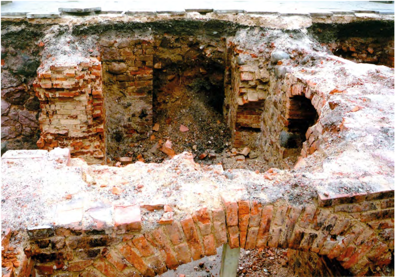
Ryc. 29. Stargard, Stare Miasto, kwartał IX. Ściana S piwnicy kamienicy Targ Drzewny 21 z zejściem z ulicy. Widok od N. Fot. T. Balcerzak
