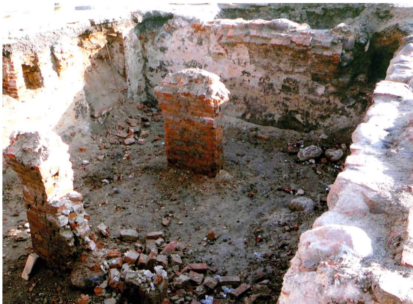
Ryc. 8. Stargard, Stare Miasto, kwartał IX. Wnętrze narożnej piwnicy kamienicy Targ Drzewny 19. Widok od N-W. Fot. T. Balcerzak
