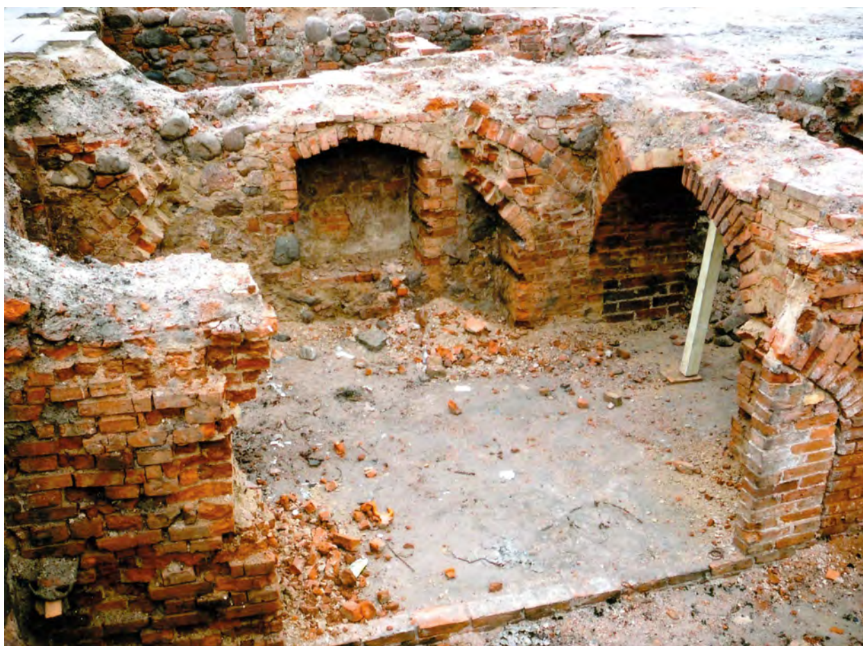
Ryc. 28. Stargard, Stare Miasto, kwartał IX. Ściana W piwnicy kamienicy Targ Drzewny 21 z niszą i reliktem filara przyściennego. Widok od S-E. Fot. T. Balcerzak Abb. 28. Stargard, Altstadt, Quartier IX. Westwand des Kellers im Bürgerhaus in der ehemaligen Holzmarktstraße 21 mit Nische und Relikt eines Wandpfeilers. Ansicht von Südosten. Foto T. Balcerzak
