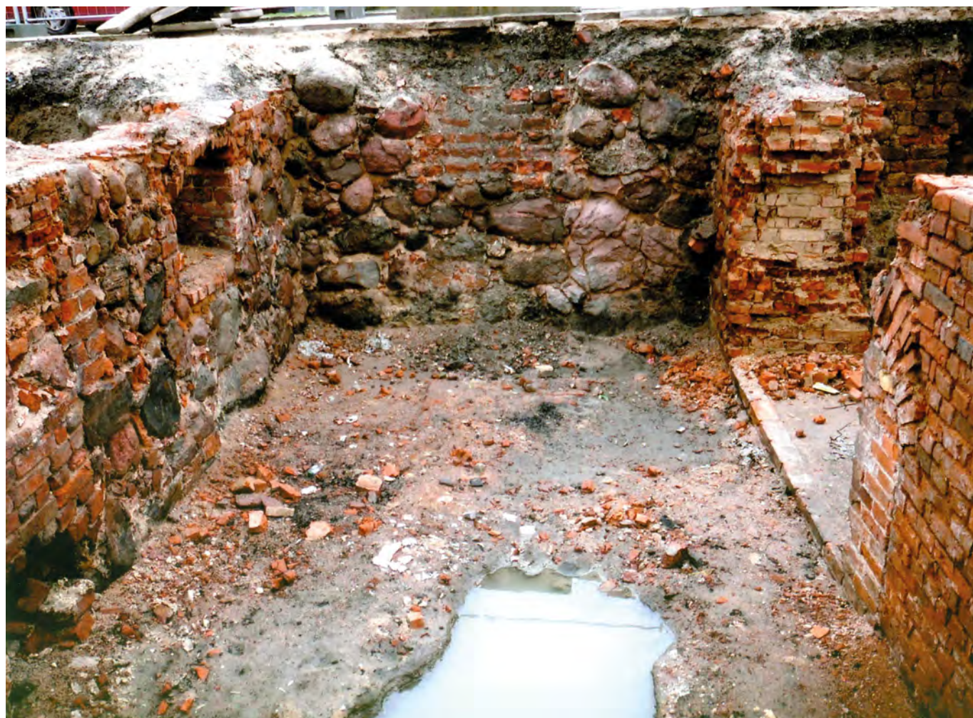
Ryc. 26. Stargard, Stare Miasto, kwartał IX. Część E piwnicy kamienicy Targ Drzewny 21. Widok od N. Fot. T. Balcerzak Abb. 26. Stargard, Altstadt, Quartier IX. Ostbereich des Kellers im Bürgerhaus in der ehemaligen Holzmarktstraße 21. Ansicht von Norden. Foto T. Balcerzak
