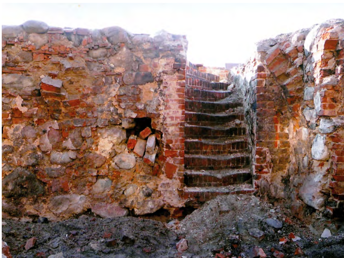
Ryc. 12. Stargard, Stare Miasto, kwartał IX. Schody łączące pierwotnie parter kamienicy Targ Drzewny 19 z piwnicą narożną. Po lewej widoczna schodkowo zamknięta nisza. Widok od N-E. Fot. T. Balcerzak Abb. 12. Stargard, Altstadt, Quartier IX. Treppe, die ursprünglich das Erdgeschoss des Bürgerhauses in der ehemaligen Holzmarktstraße 19 mit dem Eckkeller verband. Links ist eine Treppennische zu sehen. Ansicht von Nordosten. Foto T. Balcerzak
