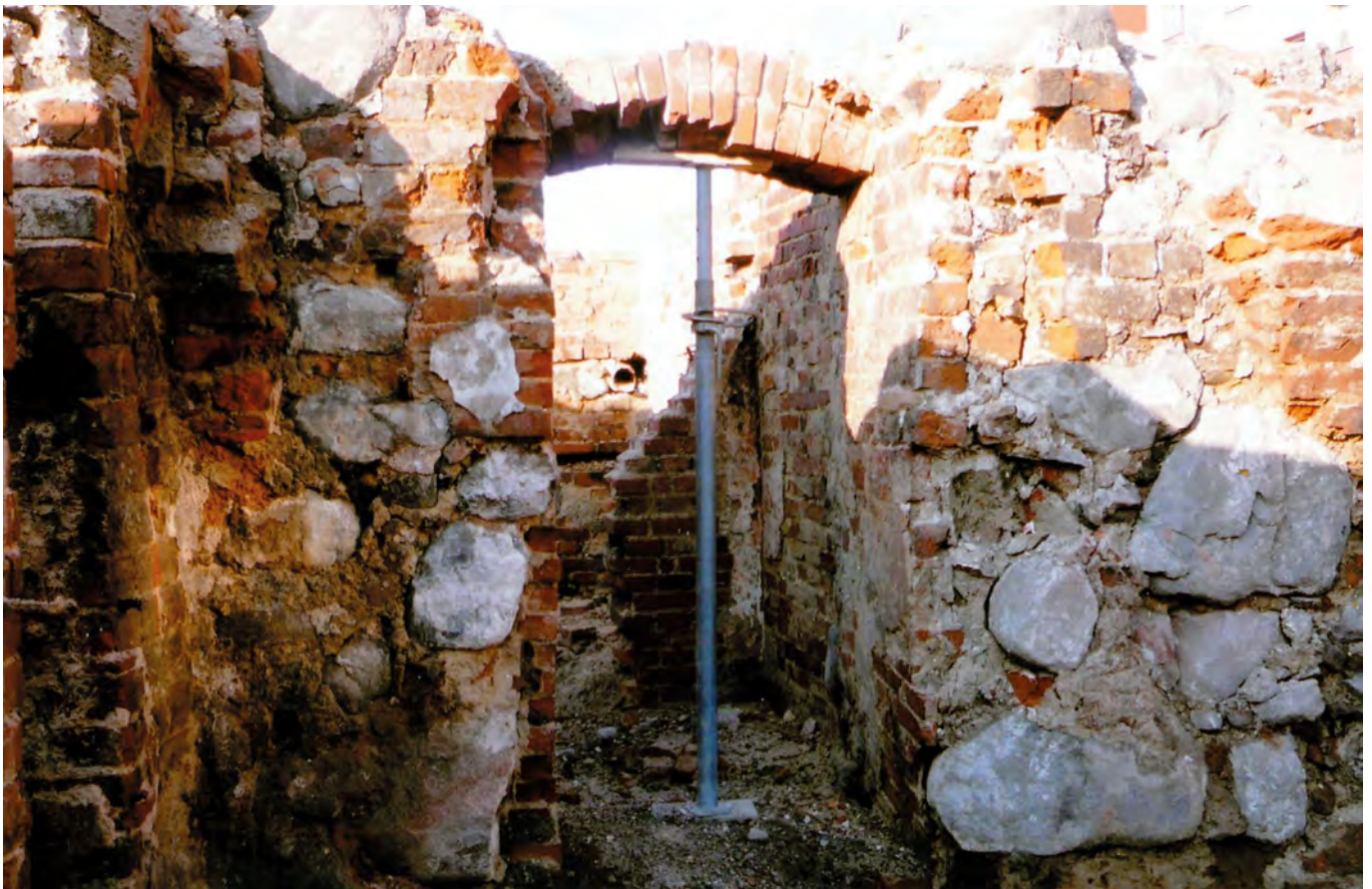
Ryc. 16. Stargard, Stare Miasto, kwartał IX. Przejście pomiędzy narożną piwnicą kamienicy a pierwotną piwnicą budy domu Targ Drzewny 19. Widok od S. Fot. T. Balcerzak Abb. 16. Stargard, Altstadt, Quartier IX. Durchgang zwischen dem Eckkeller des Bürgerhauses und dem ursprünglichen Keller der Bude vom Haus in der ehemaligen Holzmarktstraße 19. Ansicht von Süden. Foto T. Balcerzak
