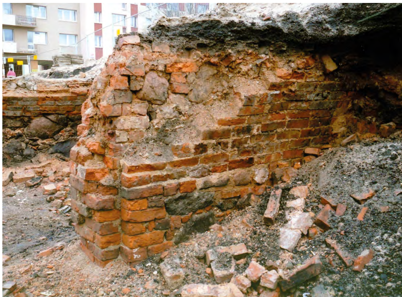
Ryc. 23. Stargard, Stare Miasto, kwartał IX. Ściana środkowa podtrzymująca sklepienia piwnicy kamienicy Targ Drzewny 20. Widok od N-W. Fot. T. Balcerzak Abb. 23. Stargard, Altstadt, Quartier IX. Mittelwand, die die Kellergewölbe im Bürgerhaus in der ehemaligen Holzmarktstraße 20 trägt. Ansicht von Nordwesten. Foto T. Balcerzak
