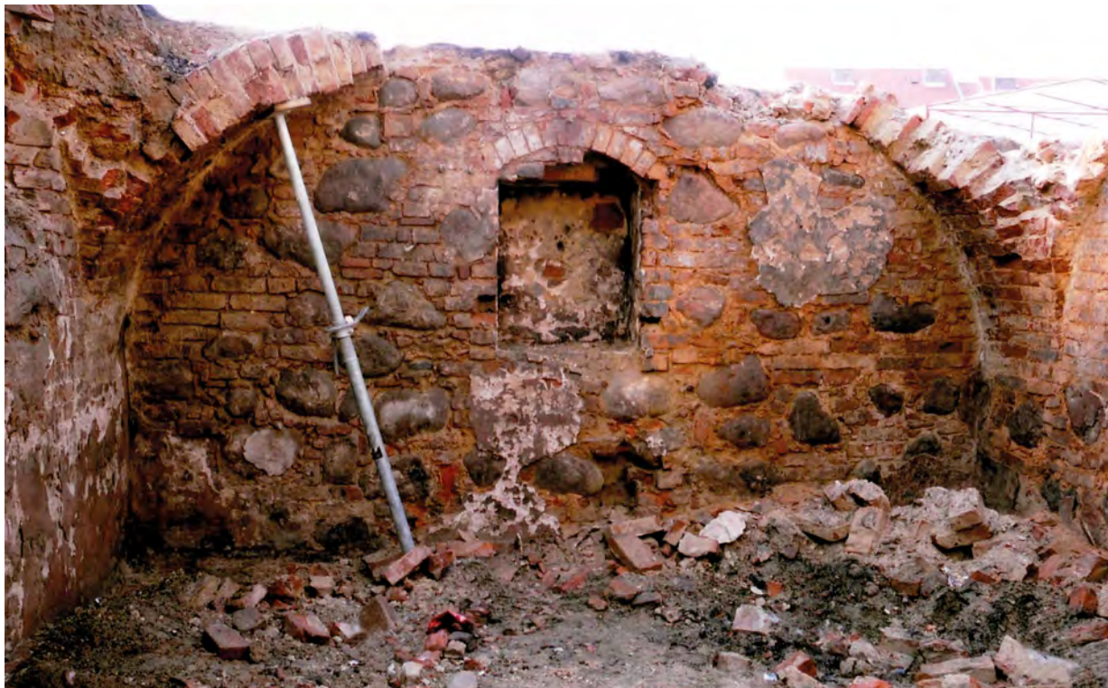
Ryc. 14. Stargard, Stare Miasto, kwartał IX. Ściana W piwnicy tylnego traktu kamienicy Targ Drzewny 19. Fot. T. Balcerzak Abb. 14. Stargard, Altstadt, Quartier IX. Westwand des Kellers des Hintertrakts vom Bürgerhaus in der ehemaligen Holzmarktstraße 19. Foto T. Balcerzak
