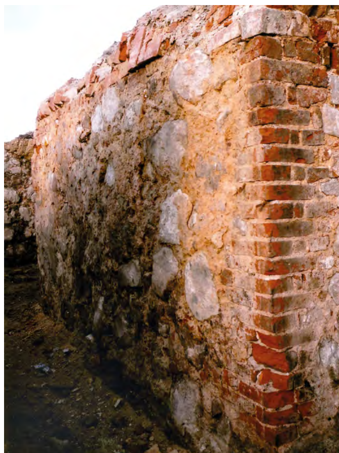
Ryc. 17. Stargard, Stare Miasto, kwartał IX. Przemuirowana część ściany E piwnicy pierwotnej budy kamienicy Targ Drzewny 19. Widok od S-W. Fot. T. Balcerzak
