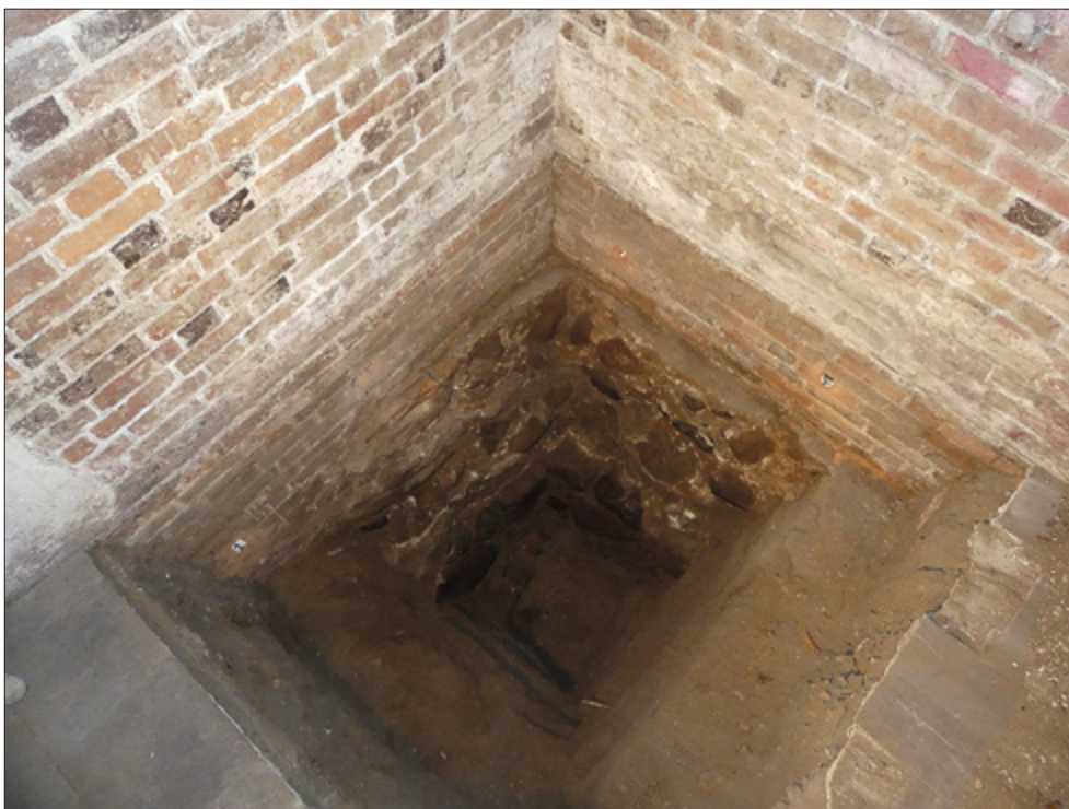
Ryc. 38. Toruń (stan. 360), kościół św. Jakuba. S-9/20 – widok z góry na północną ścianę wieży (po lewej) i zachodnią ścianę korpusu. Poniżej wendyjskiego wątku kamienny fundament bez odsadzki. Najniżej kamienna ława. Fot. B. Kriks
