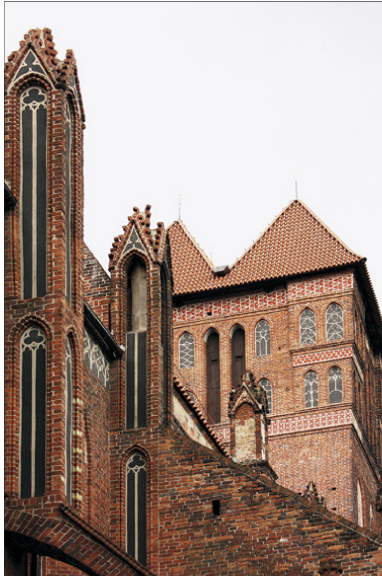
Ryc. 43. Toruń (stan. 360), kościół św. Jakuba. Widok od północy na łuk podporowy nad zakrystią. W górze dekoracyjne zakończenia skarp. Po prawej wschodni szczyt północnej kaplicy. W głębi wieża zachodnia. Fot. K. Sulowska-Tuszyńska
