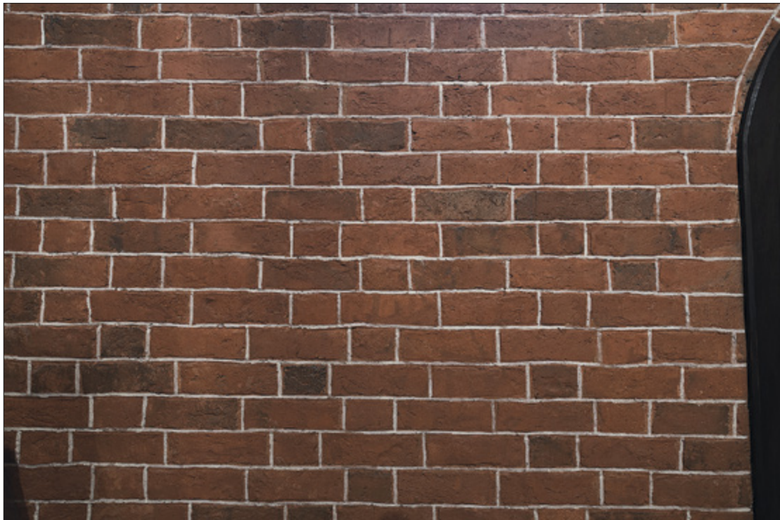
Ryc. 41. Toruń (stan. 360), kościół św. Jakuba. Ściana zachodnia od wnętrza (nad S-9/20). Widoczny wątek wendyjski. Stan po pracach konserwatorskich w 2021 r. Fot. W. Ochozny Fig. 41. Toruń (site 360), the St James church. Western wall from the inside (above S-9/20). Visible monk bond. Condition after conservation works in 2021. Photo by W. Ochozny
