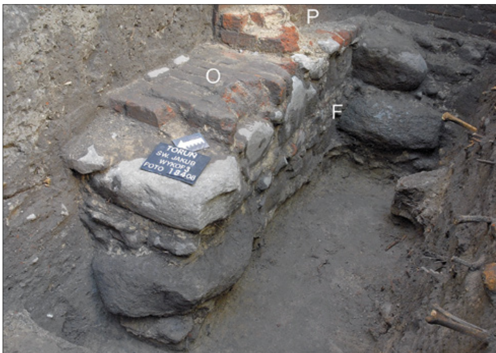
Ryc. 30. Toruń (stan. 360), kościół św. Jakuba. Prosty fundament (F) pod przekątniową przyporą P (nr 3) (W-3/08). Szeroka odsadzka (O) i wielkie kamienie węglane przy północnej ścianie prezbiterium (w głębi). Po prawej, w profilu kości ludzkie. Fot. K. Sulkowska-Tuszyńska
