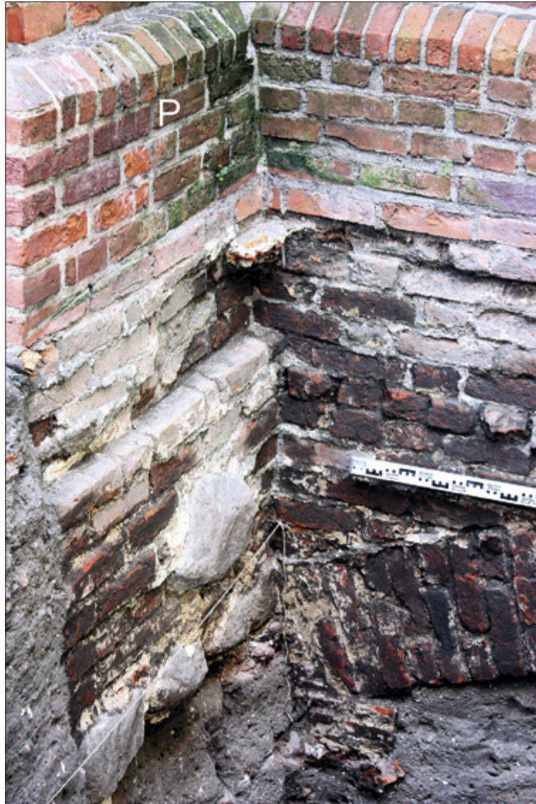
Ryc. 51. Toruń (stan. 360), kościół św. Jakuba. Wykop W-16/15. Widok od południa na arkadowy fundament ściany południowej i fundament nowej przypory P na osi kaplicy (nr 13') – zbliżenie. Fot. J. Struwe
