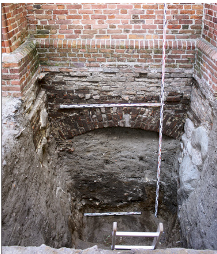
Ryc. 47. Toruń (stan. 360), kościół św. Jakuba. Wykop W-16/15. Widok na fundament kaplicy św. Walentego, od południa. Etap w trakcie odsłaniania. Fot. M. Magalski
