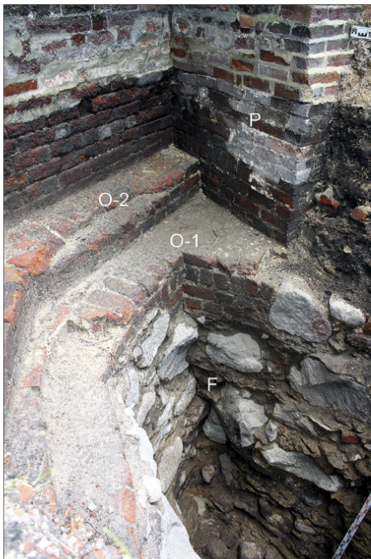
Ryc. 28. Toruń (stan. 360), kościół św. Jakuba. Kamienny fundament (F) pod narożnikiem północno-wschodnim prezbiterium (W-6/11). Widoczne dwie odsadzki (O1, O2). Po prawej przypora przekątniowa P (nr 3) na prostym fundamencie. Fot. J. Struwe
