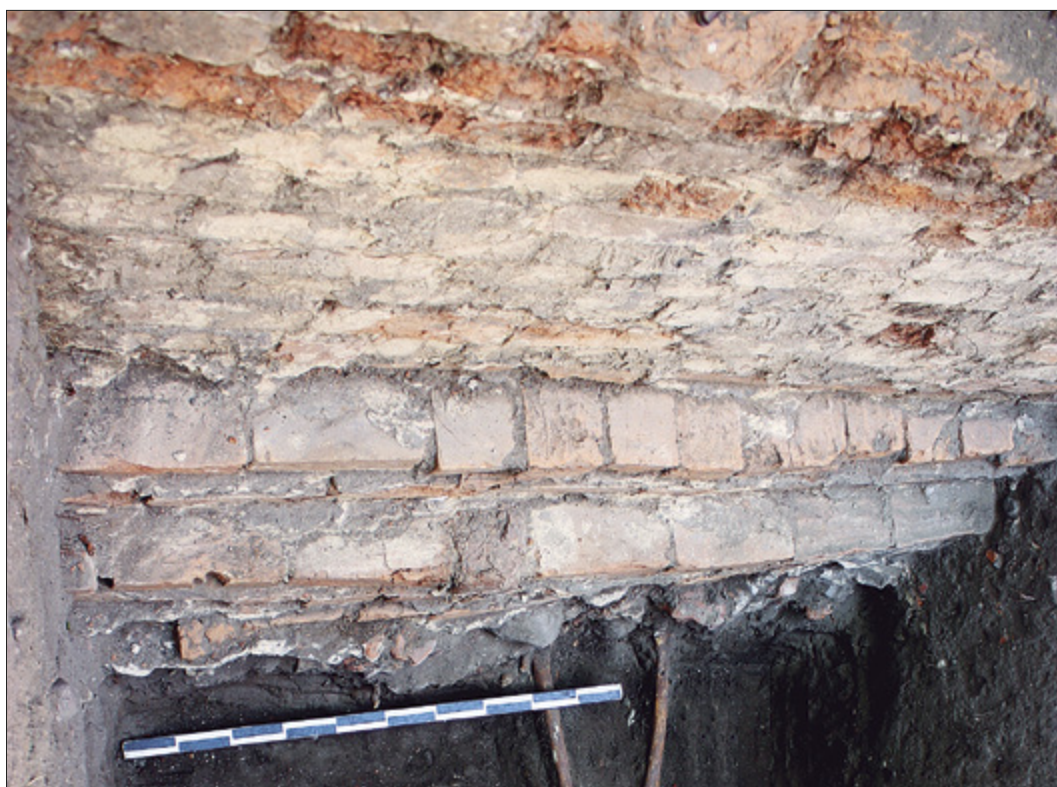
Ryc. 63. Toruń (stan. 360), kościół św. Jakuba. Wykop W-8/11. Łącznik – widok z góry na odsadzki łącznika. Na dnie pochówek pod stopą fundamentu. Fot. A. Cicha
