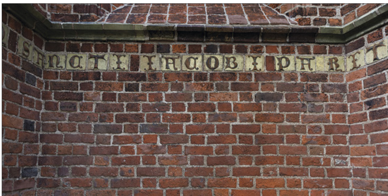
Ryc. 10. Toruń (stan. 360), kościół św. Jakuba. Ceramiczne inskrypcje i wątki muru na zewnątrz, od południa. Fot. J. Struwe, W. Ochotny Fig. 10. Toruń (site 360), the St James church. Ceramic inscriptions and bonds of the wall outside, from the south. Photo by J. Struwe and W. Ochotny
