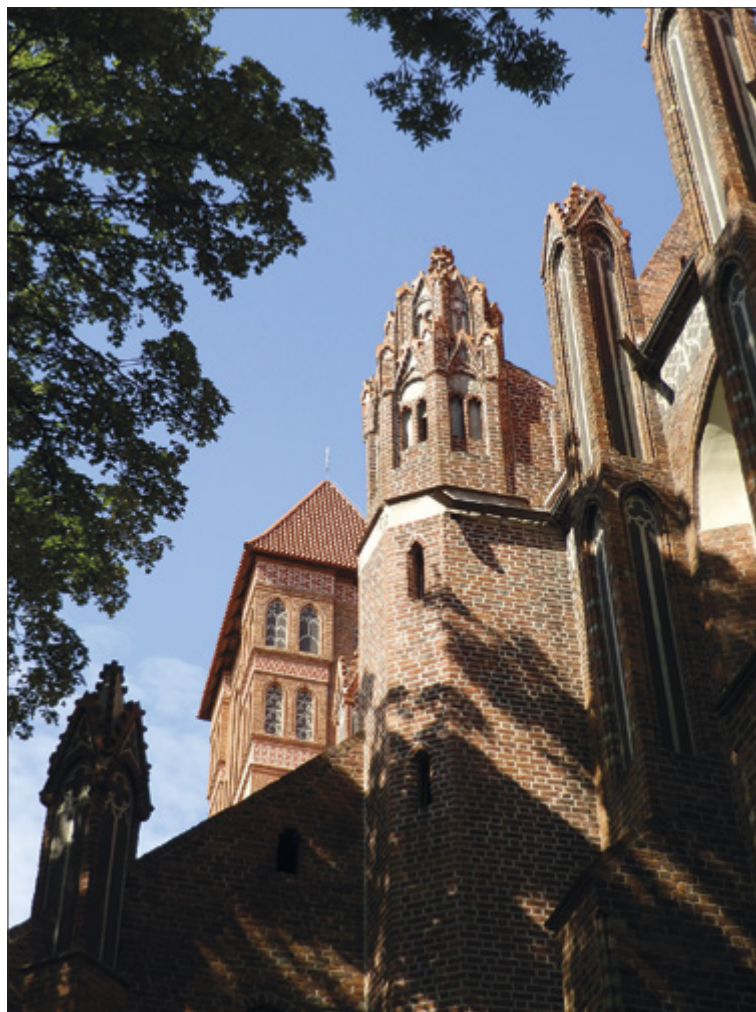
Ryc. 9. Toruń (stan. 360), kościół św. Jakuba. Prezbiterium na styku z korpusem nawowym od południa. Widok na wieżyczkę schodową. Fot. A. Cicha
