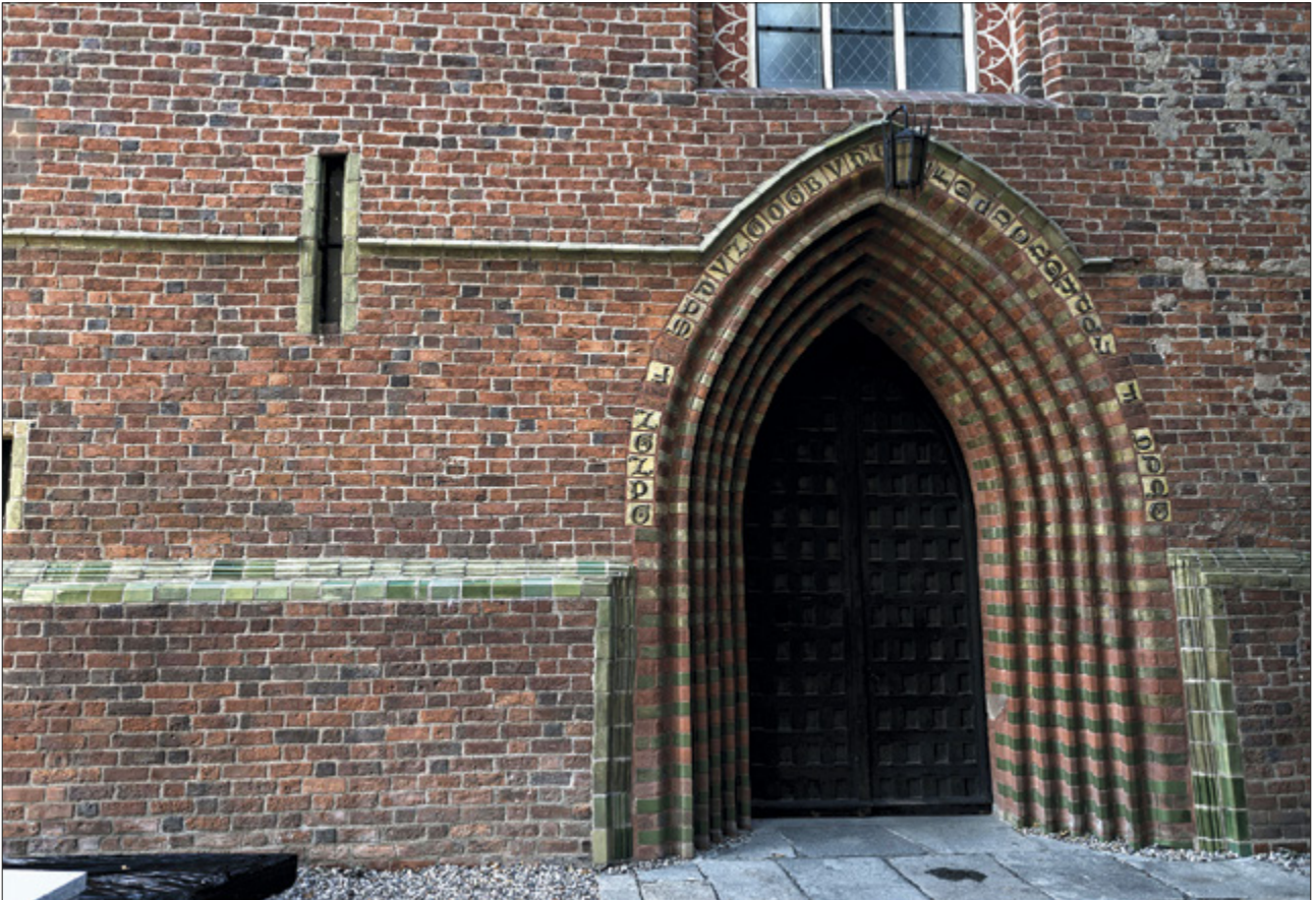
Ryc. 40. Toruń (stan. 360), kościół św. Jakuba. Fasada zachodnia z portalem głównym. Widoczny wątek wendyjski. Fot. W. Ochozny Fig. 40. Toruń (site 360), the St James church. West facade with the main portal. Visible monk bond. Photo by W. Ochozny
