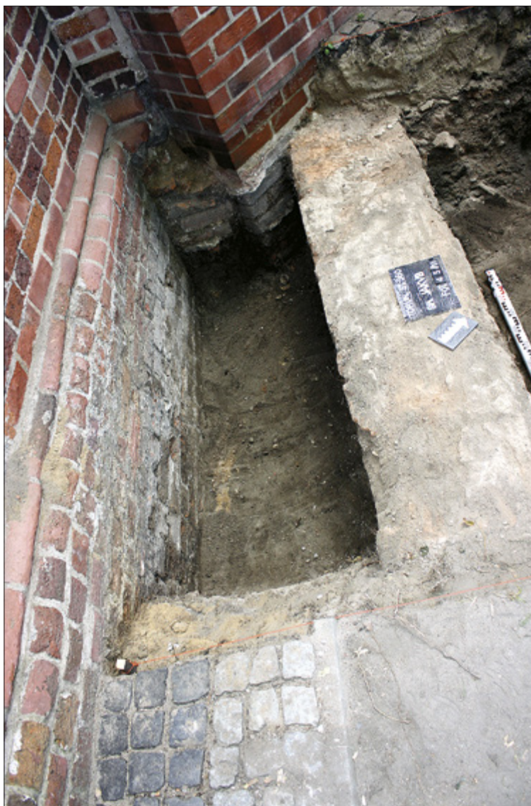
Ryc. 61. Toruń (stan. 360), kościół św. Jakuba – teren na południe od portalu bocznego. W-8/11 – zachodni fundament łącznika wzdłuż wschodniej ściany kaplicy południowej. Widok z góry, od południa. Fot. J. Struwe
