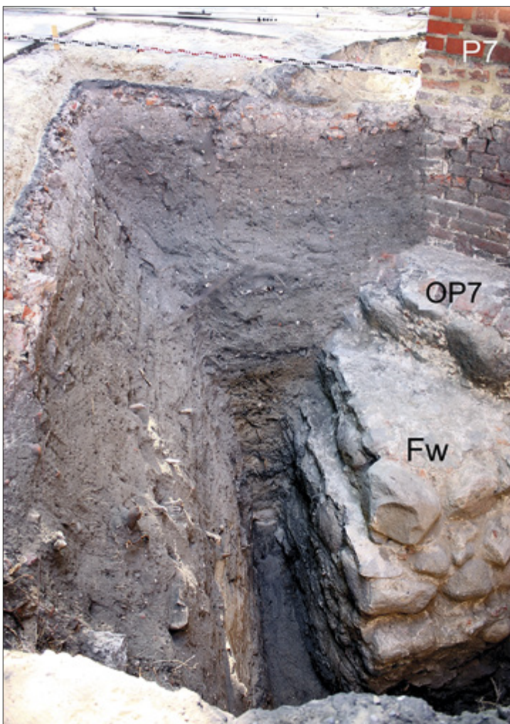
Ryc. 33. Toruń (stan. 360), kościół św. Jakuba. W-15/15 – wielki narożny fundament (Fw) pod przekątniową przyporą 7 (P7), z ceglana odsadzką (OP7). Fot. A. Cicha
