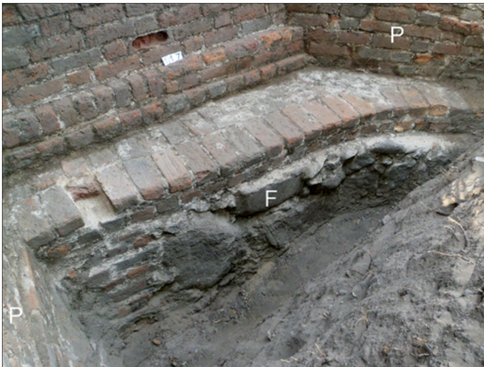
Ryc. 29. Toruń (stan. 360), kościół św. Jakuba. Jednorodny fundament (F) pod narożnikiem północno-wschodnim prezbiterium (S-6/15). Widoczna szeroka odsadzka. Po prawej, przypora przekątniowa P (nr 4), po lewej, przypora prosta (nr 5). Fot. A. Cicha
