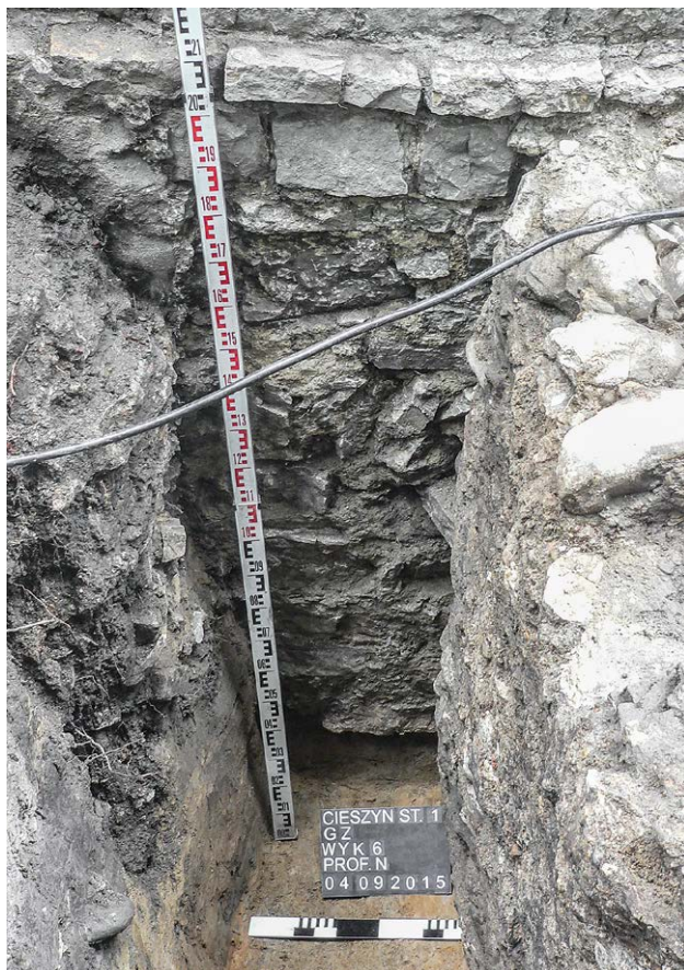
Il. 4.1.55 Wykop 6/2016, lico muru rotundy z zaburzeniami i poziom posadowienia muru 6 od strony zachodniej (fot. Z. Jagosz-Zarzycka) ¶ Trench 6/2016 – face of the wall of the rotunda with distortions and the level of the foundation of the wall no. 6 from the West (photo: Z. Jagosz-Zarzycka)
