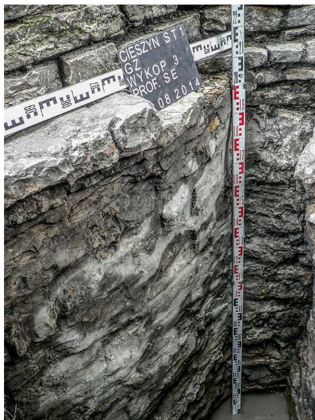
Il. 7.4.11 Wykop 3. Fundament północnego odcinka apsydy i jej styku z nawą, w licu widoczna zaprawa cementowa (fot. Z. Jagosz-Zarzycka) ¶ Trench 3 – foundation at the meeting point of the apse and the nave from the N; some cement mortar on the face of the wall (photo: Z. Jagosz-Zarzycka)
