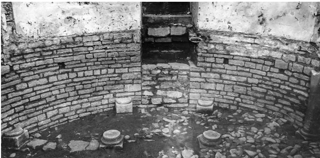
Il. 4.1.10b Główne wejście do kaplicy zamurowane w dolnej części, przestrzeń między murem zewnętrznym i wewnętrznym jest wypełniona luźną ziemią, badania G. Raschkego, 1941 (fot. R. Hesse) ¶ Main entrance to the chapel walled up in the lower part; open space between the outer and inner walls is filled with loose earth, G. Raschke's research, 1941 (photo: R. Hesse)
