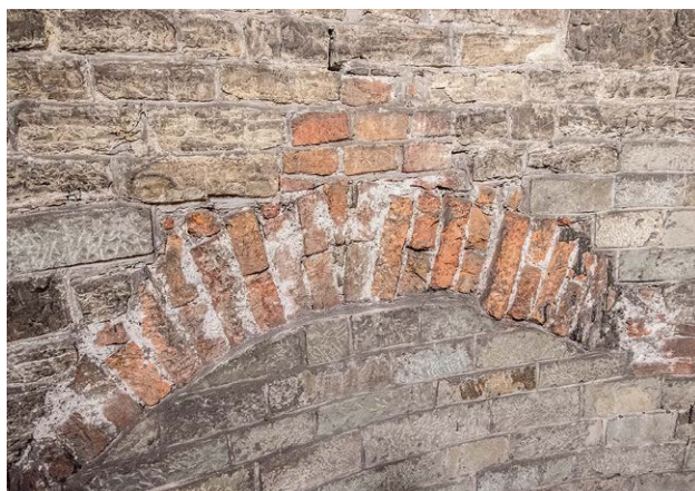
Il. 7.3.18 Ceglany łuk na poziomie empory (fot. T. Rodzińska-Choraży) ¶ Brick arch at the level of the gallery (photo: T. Rodzińska-Choraży)
