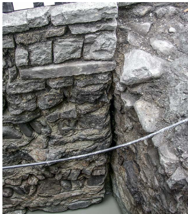
Il. 7.4.5 Wykop 1. Dylatacja między fundamentem rotundy a murem 1 (fot. T. Rodzińska-Choraży) ¶ Trench 1 – expansion joint between the foundation of the rotunda and the wall no. 1 (photo: T. Rodzińska-Choraży)
