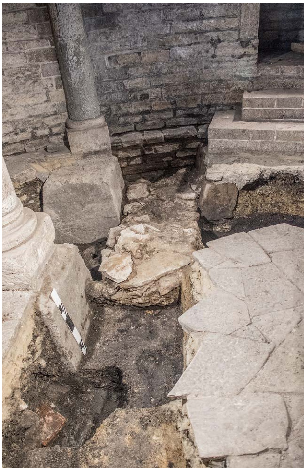
Il. 7.3.24 Betonowe fundamenty pod rekonstrukcją emporę (fot. T. Rodzińska-Choraży) ¶ Concrete foundations under the reconstructed gallery (photo: T. Rodzińska-Choraży)
