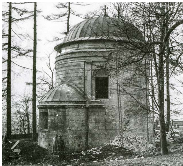
Il. 3.4 Rotunda w trakcie usuwania płaszczki klasycystycznej oraz wykopaliska w 1941 roku ¶ Rotunda in the process of removing its neoclassical plaster and the excavations in 1941
