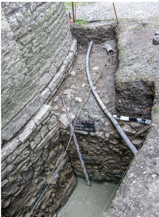
Il. 7.4.1 Wykop 1. Korona muru 1 i cokół w elewacji zewnętrznej (fot. T. Rodzińska-Choraży) ¶ Trench 1 – wall no. 1 and the plinth in the outer elevation (photo: T. Rodzińska-Choraży)
