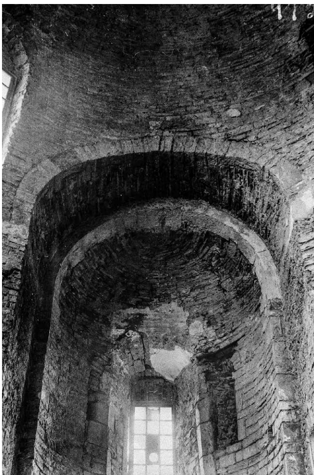
Il. 7.2.28 Pozostałości południowego okna w apsydzie, widok od wnętrza (fot. A. Müller) ¶ Remains of the southern window in the apse, inside view (photo: A. Müller)
