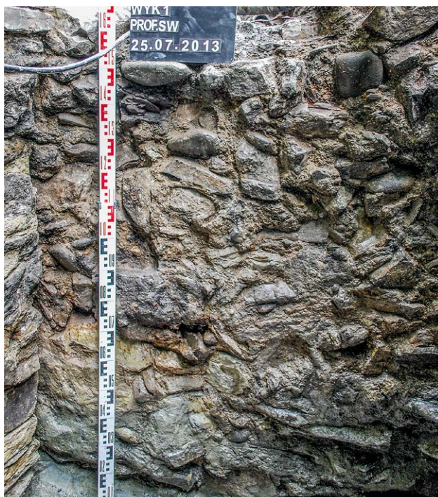
Il. 7.4.6 Wykop 1. Widok na lico wschodnie muru 1 (fot. T. Rodzińska-Choraży) ¶ Trench 1 – eastern face of the wall no. 1 (photo: T. Rodzińska-Choraży)
