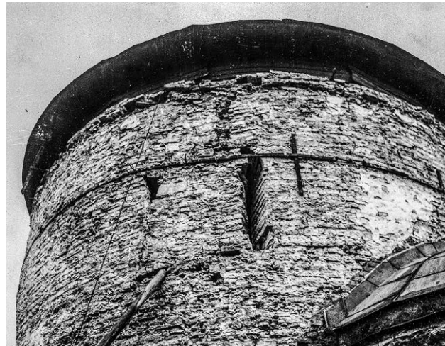
Il. 7.2.22 Lico zewnętrzne z widocznym fragmentem odkutego glifu okna południowo-wschodniego (fot. A. Müller) ¶ External face of the wall with a fragment of the splay of the s-e window (photo: A. Müller)
