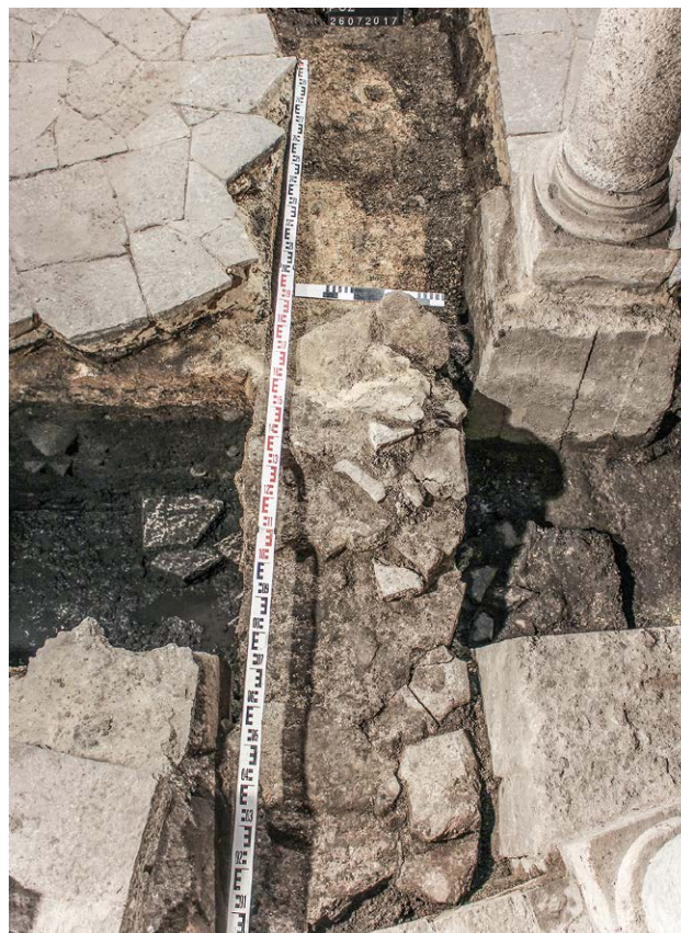
Il. 7.4.25 Wykop 9, widok z góry. Betonowe postumenty pod półkolumną przyścienną i kolumną wolnostojącą. Między nimi strop betonowej płyty (fot. Z. Jagosz-Zarzycka) ¶ Trench 9 – concrete pedestals for the columns and the concrete platform, view from above (photo: Z. Jagosz-Zarzycka)
