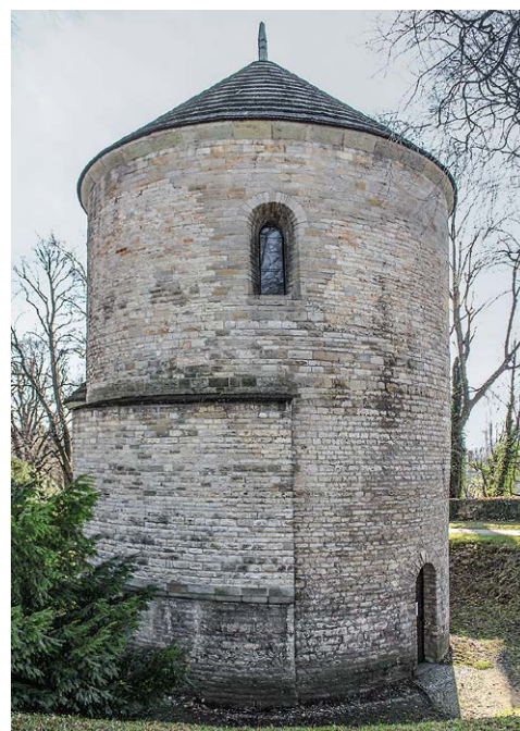
Il. 7.3.14 Bryła rotundy z ryzalitem zewnętrznym, rekonstrukcja, widok od północnego zachodu (fot. Z. Jagosz-Zarzycka) ¶ Rotunda with the reconstruction of the outer projection, view from the N-W (photo: Z. Jagosz-Zarzycka)
