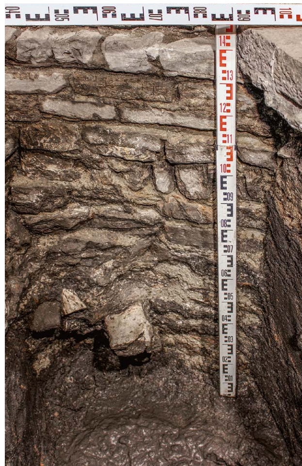
Il. 7.4.20 Wykop 9. Lico wewnętrzne fundamentu nawy FN (fot. Z. Jagosz-Zarzycka) ¶ Trench 9 – Internal face of the foundation of the northern section of the nave (photo: Z. Jagosz-Zarzycka)
