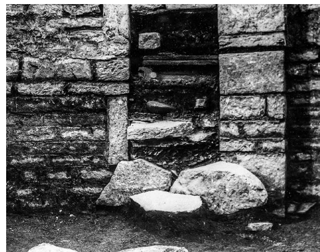
Il. 7.2.9 Dolna część zasypiska „starego” wejścia na empore (fot. A. Müller) ¶ Lower part of the fill of the “old” entrance onto the gallery (photo: A. Müller)
