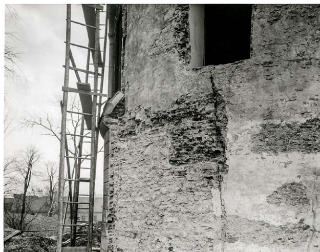
Il. 7.2.7 Lico północnej części nawy w toku likwidowania okładziny, 1941 (fot. R. Hesse) ¶ Northern face of the nave during the removal of the cladding, 1941 (photo: R. Hesse)
