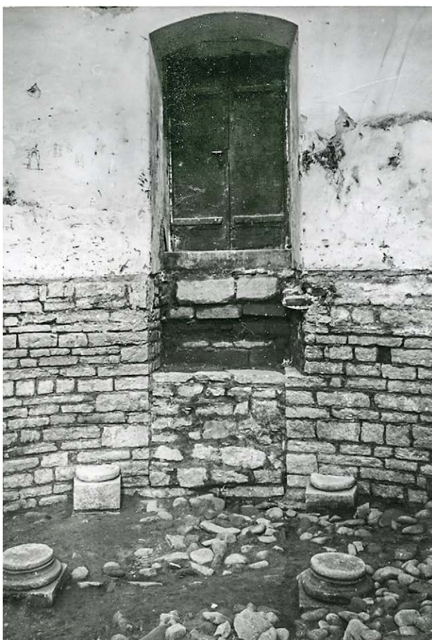
Il. 4.1.4 Wejście główne do kaplicy, od strony wewnętrznej zamurowane w dolnej części, badania G. Raschkego, 1941 (fot. R. Hesse) □ Main entrance to the chapel walled up at the bottom from the inside, G. Raschke's research, 1941 (photo: R. Hesse)
