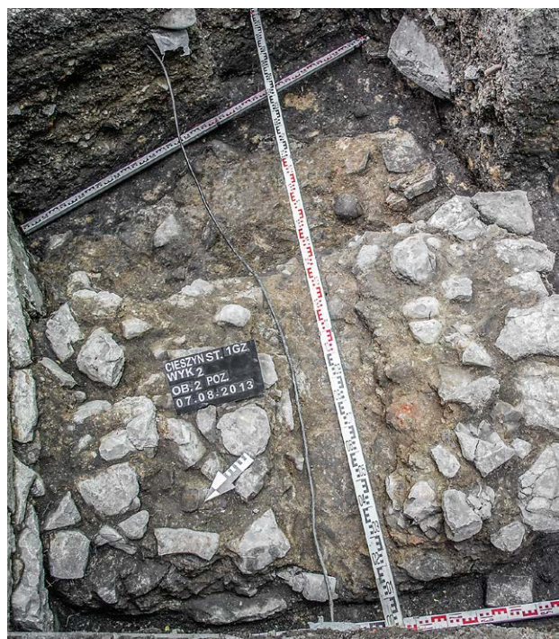
Il. 7.4.7 Wykop 2. Mur 2, Widok od wschodu, na pierwszym planie ubytek fundamentu i zniszczenie korony (fot. Z. Jagosz-Zarzycka) ¶ Trench 2 – wall no. 2, view from the E (photo: Z. Jagosz-Zarzycka)
