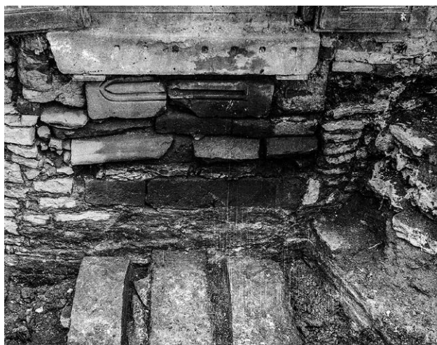
Il. 7.2.25 Zamurowane wejście do rotundy, widok od zewnątrz, w licu gotyckie detale użyte jako gruz (fot. A. Müller) ¶ Walled up entrance to the rotunda with Gothic details used as rubble, outside view (photo: A. Müller)
