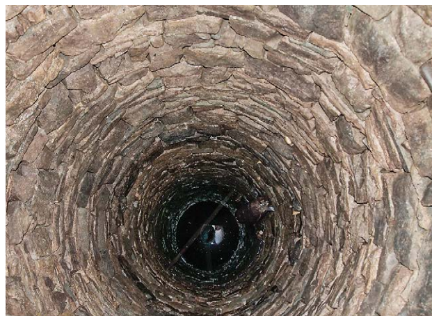
Il. 1.7 Kamienna cembrowina studni przy budynku informacji turystycznej na Górze Zamkowej (fot. A. Tyc) ¶ Stone well cribbing at the building housing the tourist information office on the Castle Hill (photo. A. Tyc)
