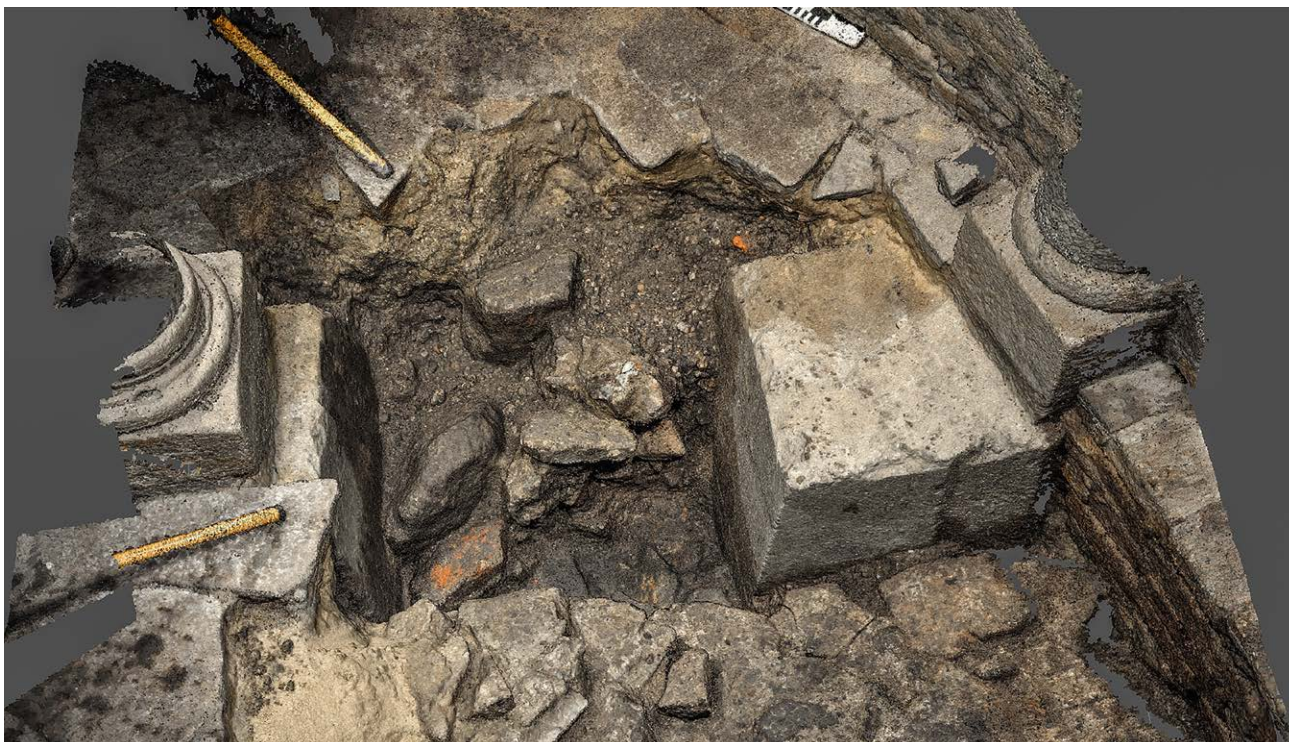
Il. 7.4.34 Ortofotomapa: widok na koronę muru mR i betonowe fundamenty pod kolumny empory, widok od wschodu (oprac. Ł. Łukaszewski)
