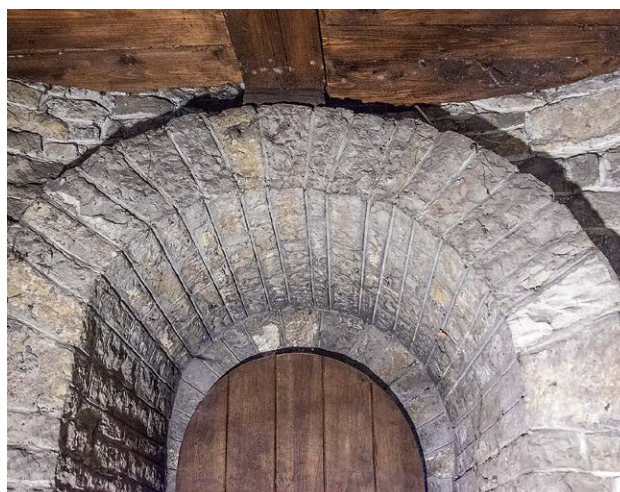
Il. 7.3.10 Portal główny na osi rotundy, rekonstrukcja, widok od wnętrza (fot. T. Rodzińska-Chorąży) ¶ Reconstruction of the main portal, inside view (photo: T. Rodzińska-Chorąży)
