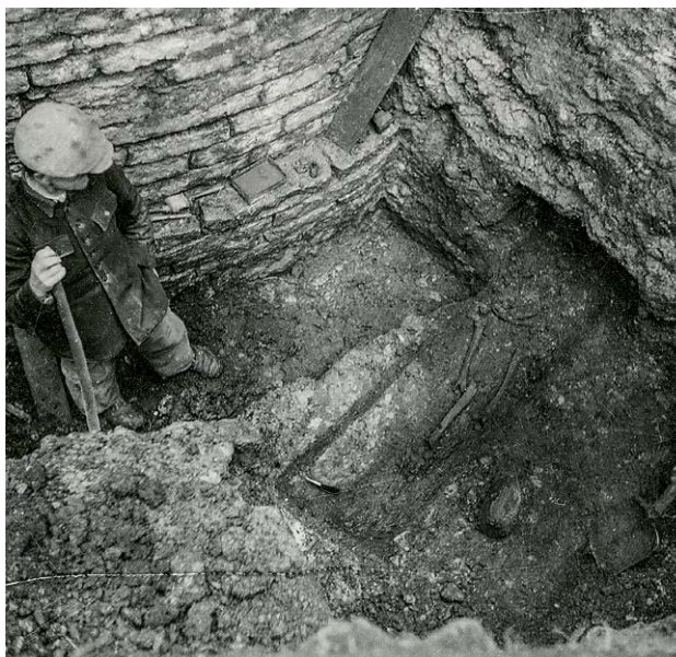
Il. 7.2.31 Wykop zewnętrzny z dobrze widocznym cokołem w dolnej części muru rotundy ¶ External trench with the plinth in the lower part of the wall of the rotunda
