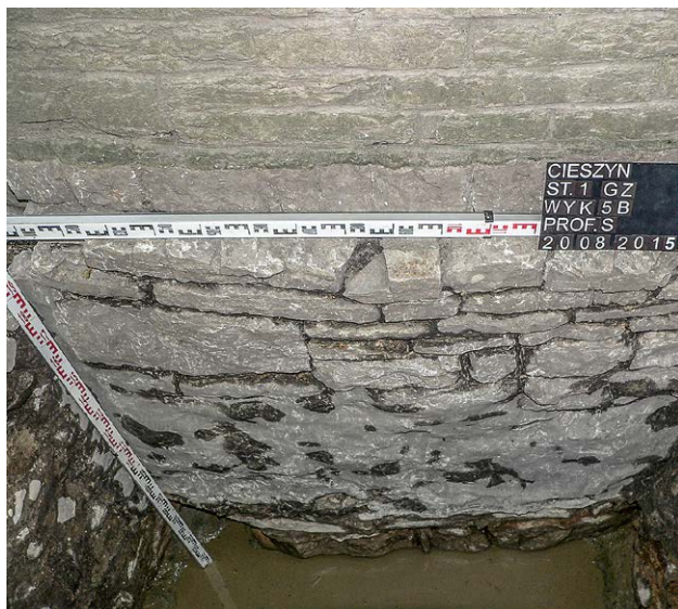
Il. 7.4.14 Wykop 5b. Mur fundamentowy rotundy między murami 3 i 5 (fot. Z. Jagosz-Zarzycka) ¶ Trench 5b – foundation wall of the rotunda between the walls nos. 3 and 5 (photo: Z. Jagosz-Zarzycka)
