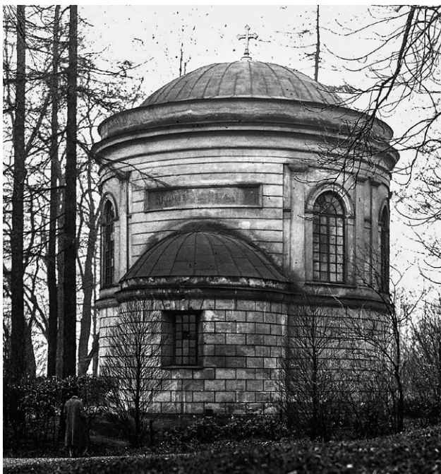
Il. 7.1.9 Widok rotundy od strony wschodniej, z tablicą upamiętniającą przebudowę, fotografia, 1926 ¶ Rotunda with the memorial plaque commemorating the rebuilding, view from the E, photograph from 1926
