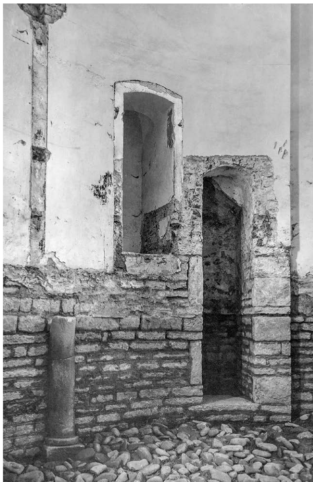
Il. 7.3.25a Wejście do klatki schodowej i pierwotny poziom posadzenia półkolumny (fot. R. Hesse) ¶ Entrance to the staircase and the original position of the engaged column (photo: R. Hesse)
