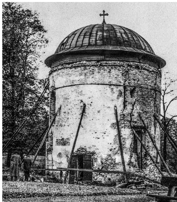
Il. 7.3.2 Otwór wejściowy od południowego zachodu na poziomie empory bez zamurowania, 1942 (fot. A. Müller) ¶ Unblocked doorway at the level of the gallery from s-w, 1942 (photo: A. Müller)
