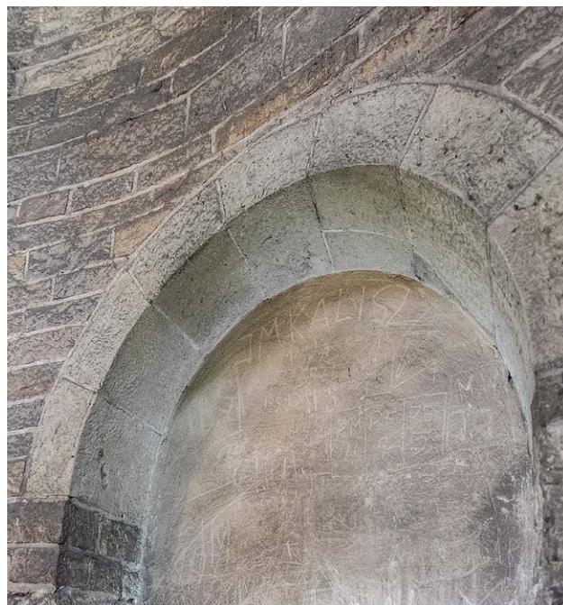
Il. 7.3.13 Portal w południowo-zachodniej części nawy na poziomie empory, rekonstrukcja łuku od strony wnętrza (fot. T. Rodzińska-Choraży) ¶ Portal on the gallery, reconstruction of the arch from the inside (photo: T. Rodzińska-Choraży)
