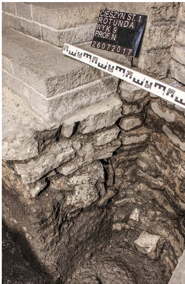
Il. 7.4.21 Wykop 9. Wschodnie lico muru FS z widoczną dylatacją i poszerzeniem fundamentu FN (fot. Z. Jagosz-Zarzycka) ¶ Trench 9 – eastern face of the foundation of the steps (photo: Z. Jagosz-Zarzycka)
