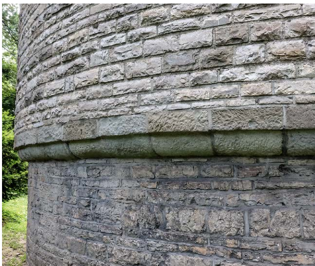
Il. 7.3.15 Nadwieszona część ryzalitu zewnętrznego, wspornik, rekonstrukcja (fot. T. Rodzińska-Chorąży) ¶ Reconstruction of the overhanging part of the outer projection, corbel (photo: T. Rodzińska-Chorąży)
