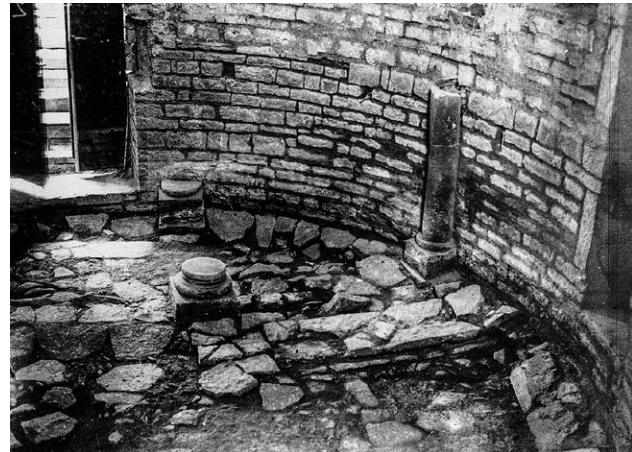
Il. 4.1.6 Najstarsza posadzka z płyt wapiennych, przy ścianach widoczne obniżenie poziomu pod naporem młodszych nawarstwień, badania G. Raschkego, 1942 (fot. A. Müller) ¶ Oldest floor paved with limestone slabs, at the walls a bend of the floor level is visible due to the pressure of the younger layers, G. Raschke's research, 1942 (photo: A. Müller)
