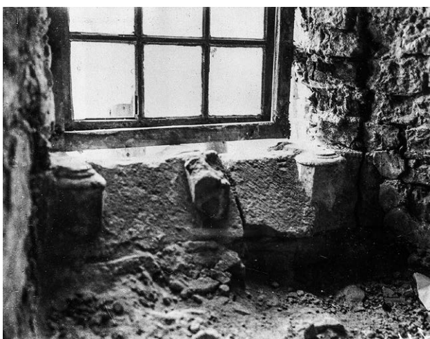
Il. 7.2.12 Parapet gotyckiego okna z pozostałościami wielobocznych baz kolumniek oraz nasadą środkowej laski (fot. A. Müller) ¶ Gothic window sill with remains of the architectural details (photo: A. Müller)
