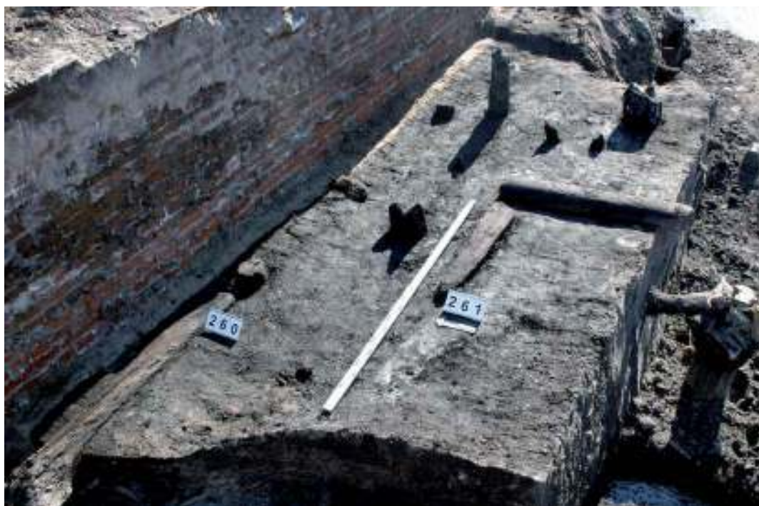
Ryc. 88. Wrocław, pl. Nowy Targ, wykop 2010–2012. Js. 260, 261. Fot. P. Duma
