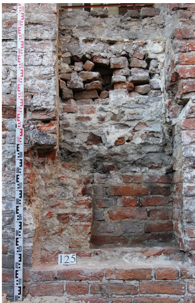
Ryc. 4. Gdańsk, Świętojańska 6-7, stanowisko 121, AZP 12-44/238. Wnęka w murze M4. Fot. J. Dąbal.
