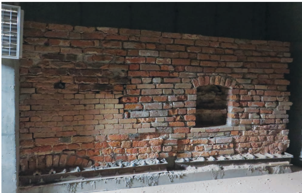
Ryc. 6. Gdańsk, Św. Ducha 68. Przykład kompozycji historycznych murów kamienic w nowym wnętrzu. Stan surowy, przed adaptacją. Fot. K. Szczepanowska.
