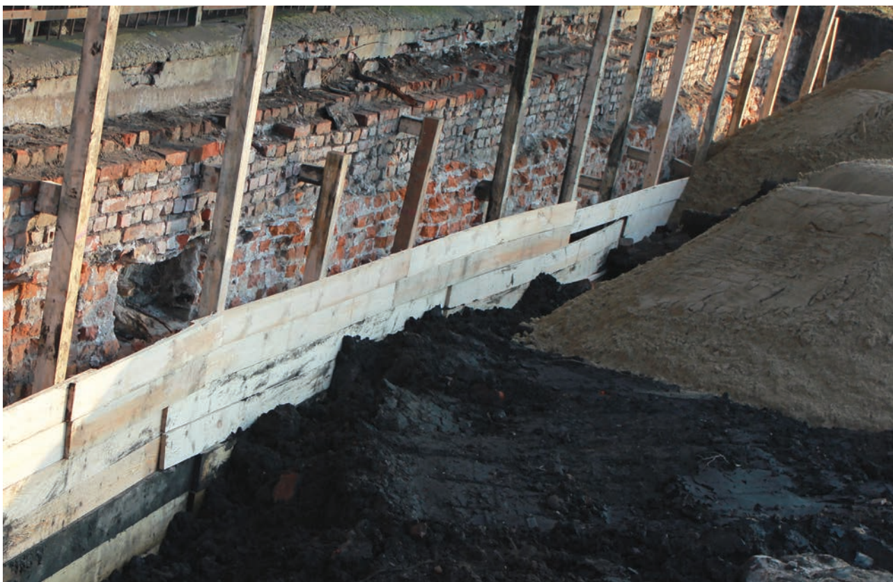
Ryc. 7. Gdańsk, Podwale Przedmiejskie działka 517/7. Przykład zabezpieczenia średniowiecznego muru po zakończeniu badań. Fot. K. Szczepanowska.
