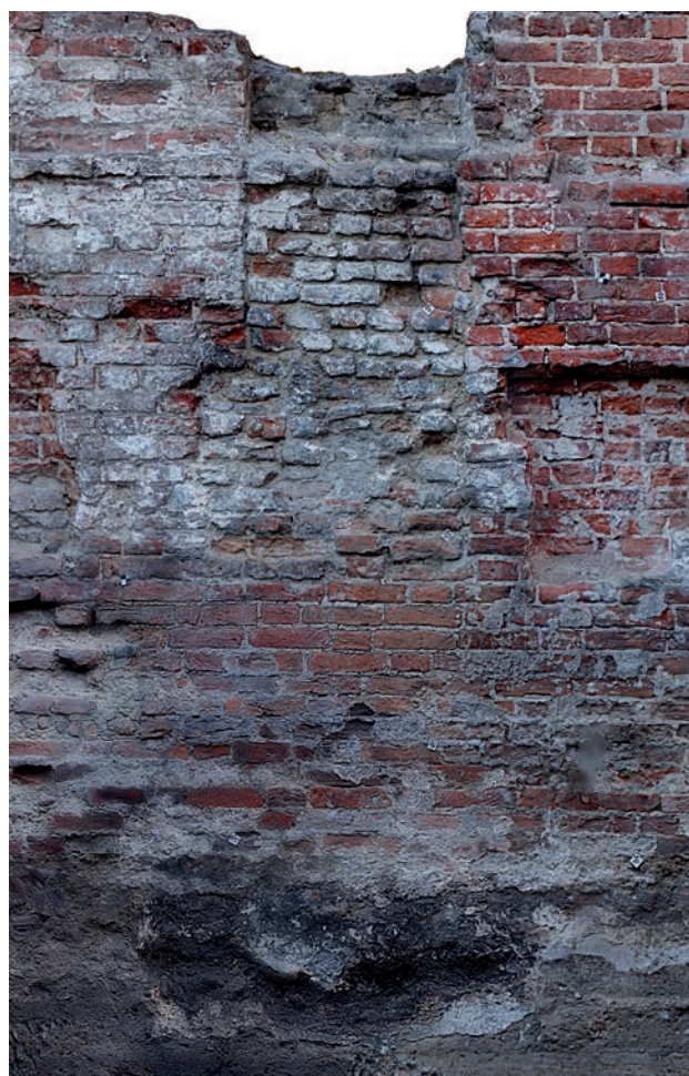
Ryc. 5. Gdańsk, Świętojańska 6-7, stanowisko 121, AZP 12-44/238. Zamurowana wnęka w murze M4 w kontekście lokalizacji obiektu. Ortofotomapa K. Daliga, T. Widerski.
