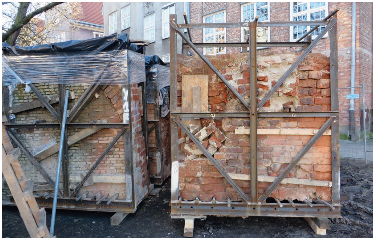
Ryc. 5. Gdańsk, Św. Ducha 68. Historyczne mury kamienic przeznaczone do zachowania, w trakcie tymczasowego przeniesienia z wykopu na czas wykonywania fundamentów nowej zabudowy. Fot. K. Szczepanowska.
