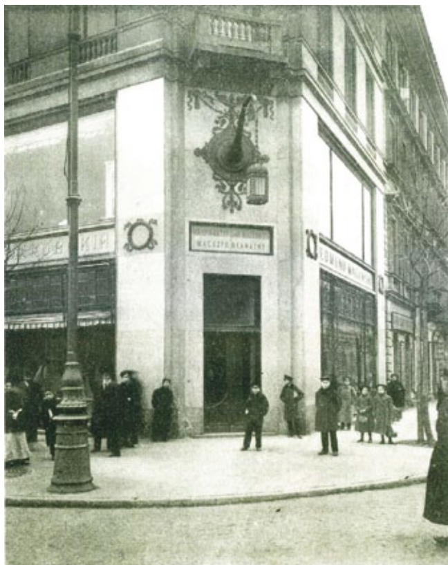
Ryc. 8. Kamienica Heurichowska, widok narożnika w 1912 r. („Przegląd Techniczny” 1912, nr 29).
