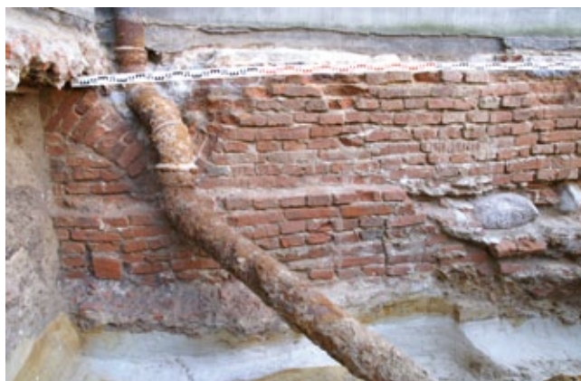
Ryc. 20. Wykop VII. Południowa część fundamentu pod wschodnią ścianą ryzalitu bramnego. Fot. M. Hrynczyszyn.
