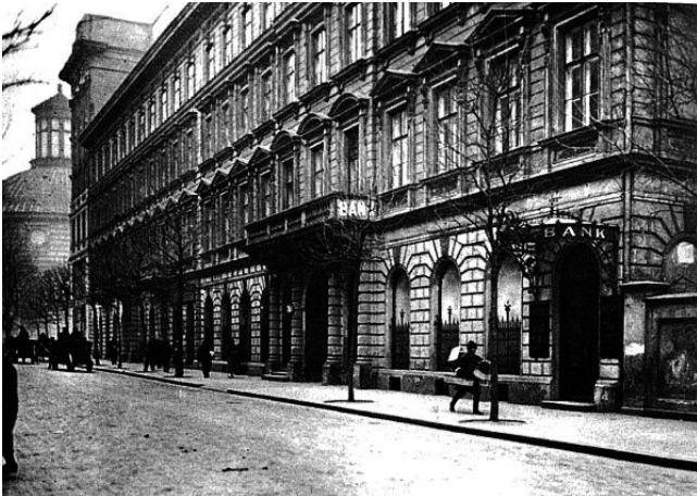
Ryc. 3. Kamienice przy ul. Traugutta 6 i 8 w okresie międzywojennym ( www.warszawa1939.pl ).
