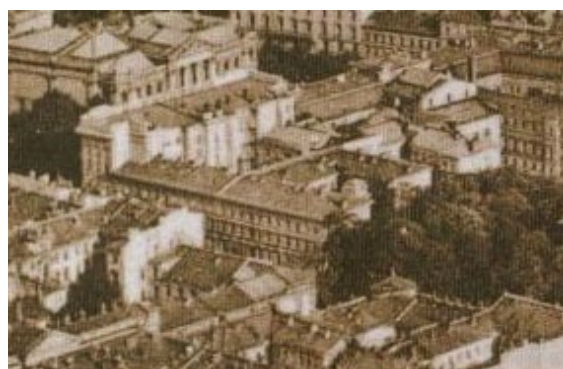
Ryc. 2. Kamienice przy ul. Traugutta 6 i 8 wraz z oficynami ok. 1912 r. Fot. T. Jankowski (IS PAN neg. nr 8435B)
