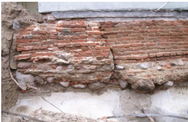
Ryc. 18. Wykop VI, odcinek 2, profil południowy. Wschodnia część fundamentu północnej ściany ryzalitu bramnego. Fot. M. Hrynczyszyn.
