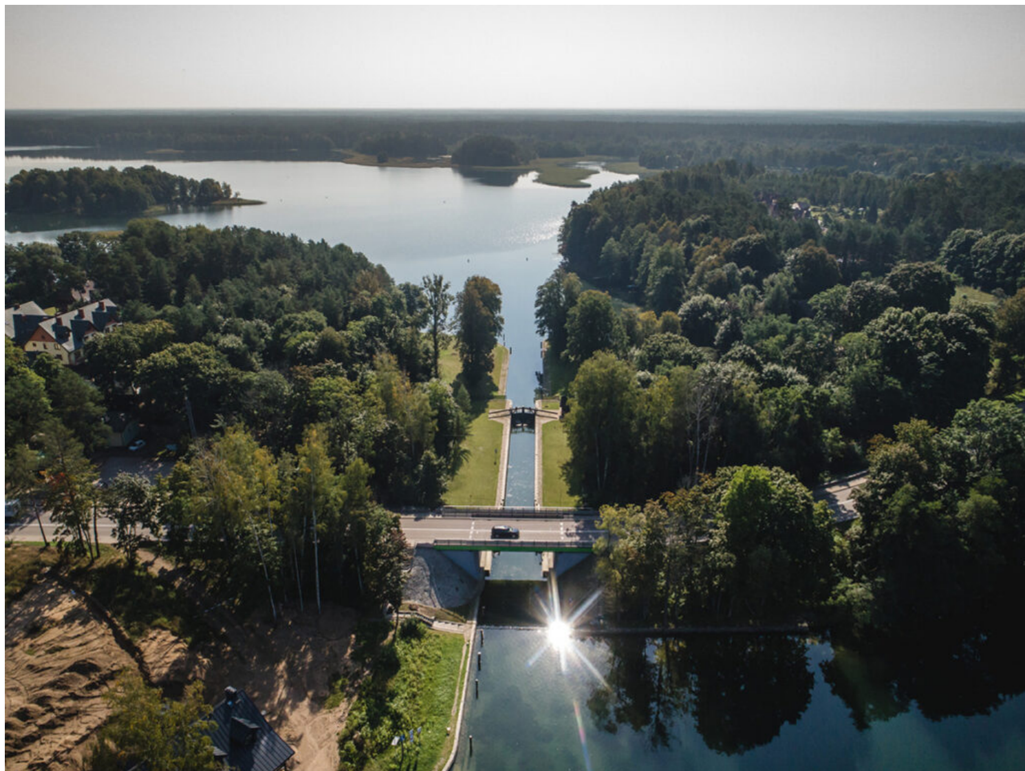
Kanał Augustowski - Jezioro Studzieniczne i śluza Przewięź, stan z 2021 r., fot. Piotr Sekuła, zb. NID
