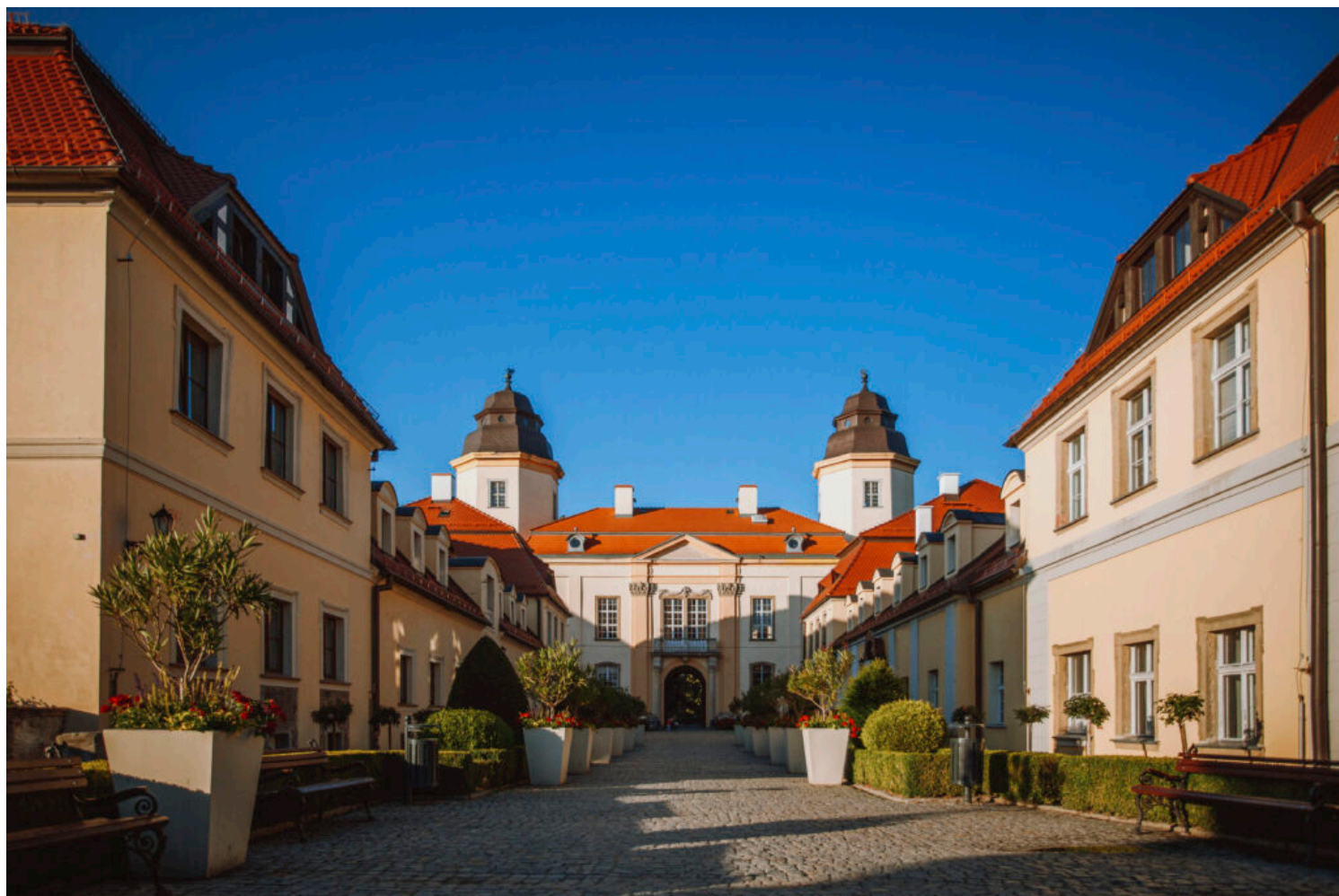
Budynek Bramny i budynki towarzyszące, fot. Maciej Jabłoński F11
