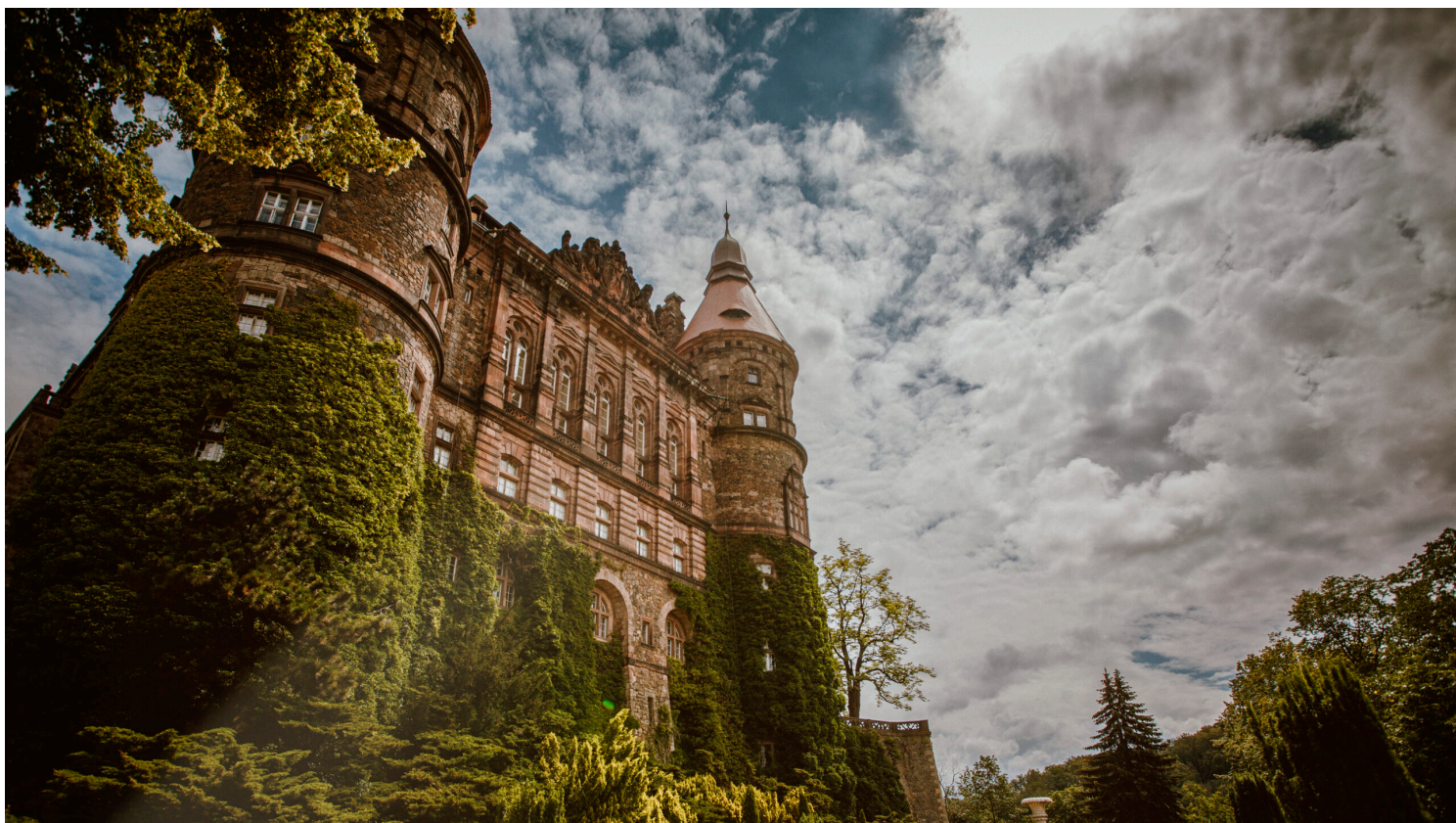
Elewacja zachodnia, fot. Maciej Jabłoński F11
