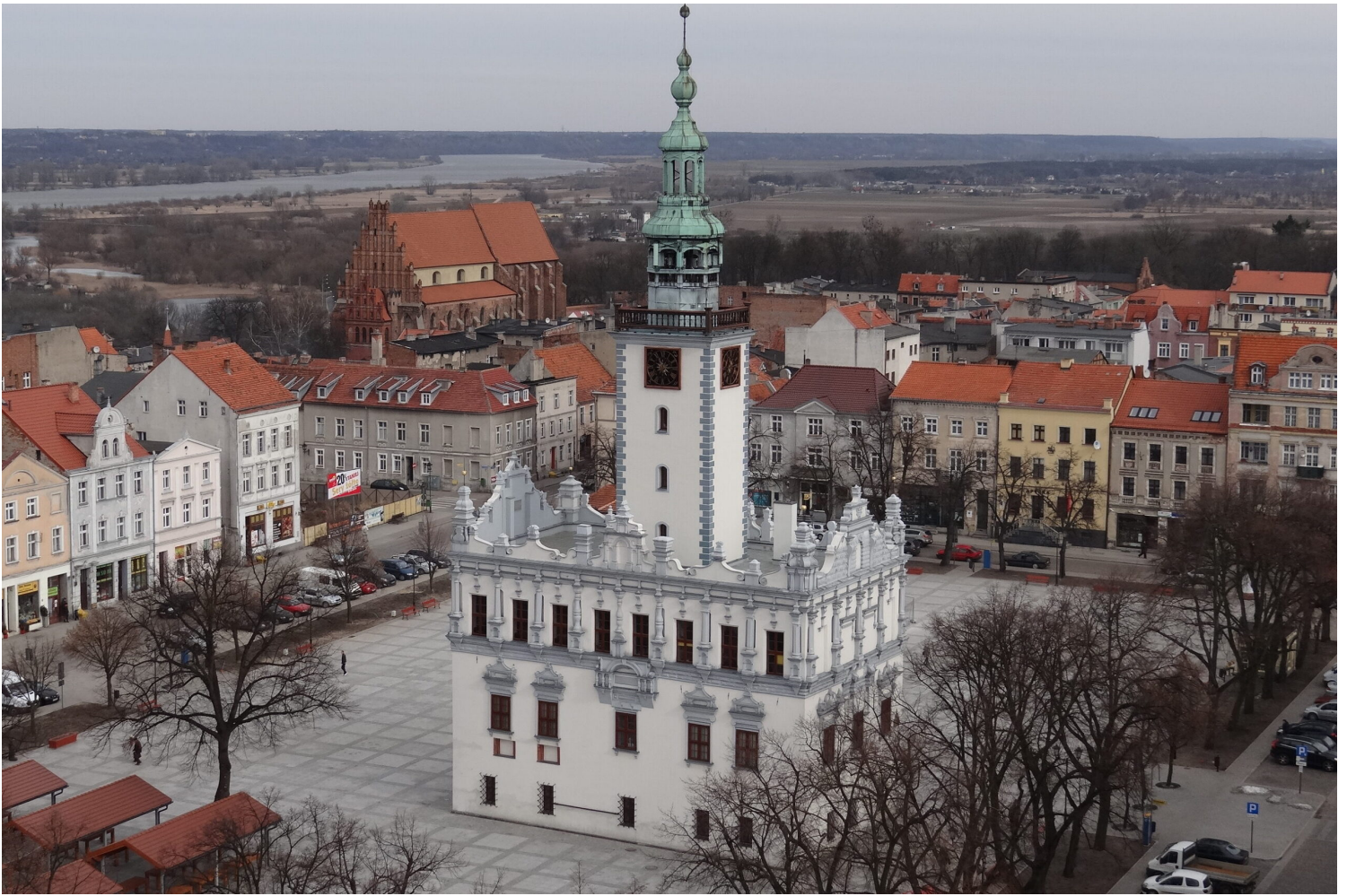
Ratusz w Chełmnie – akcent urbanistyczny, dzieło architektury, świadek historii, zabytek zadbany (fot. A. Paczuski, 2013).
