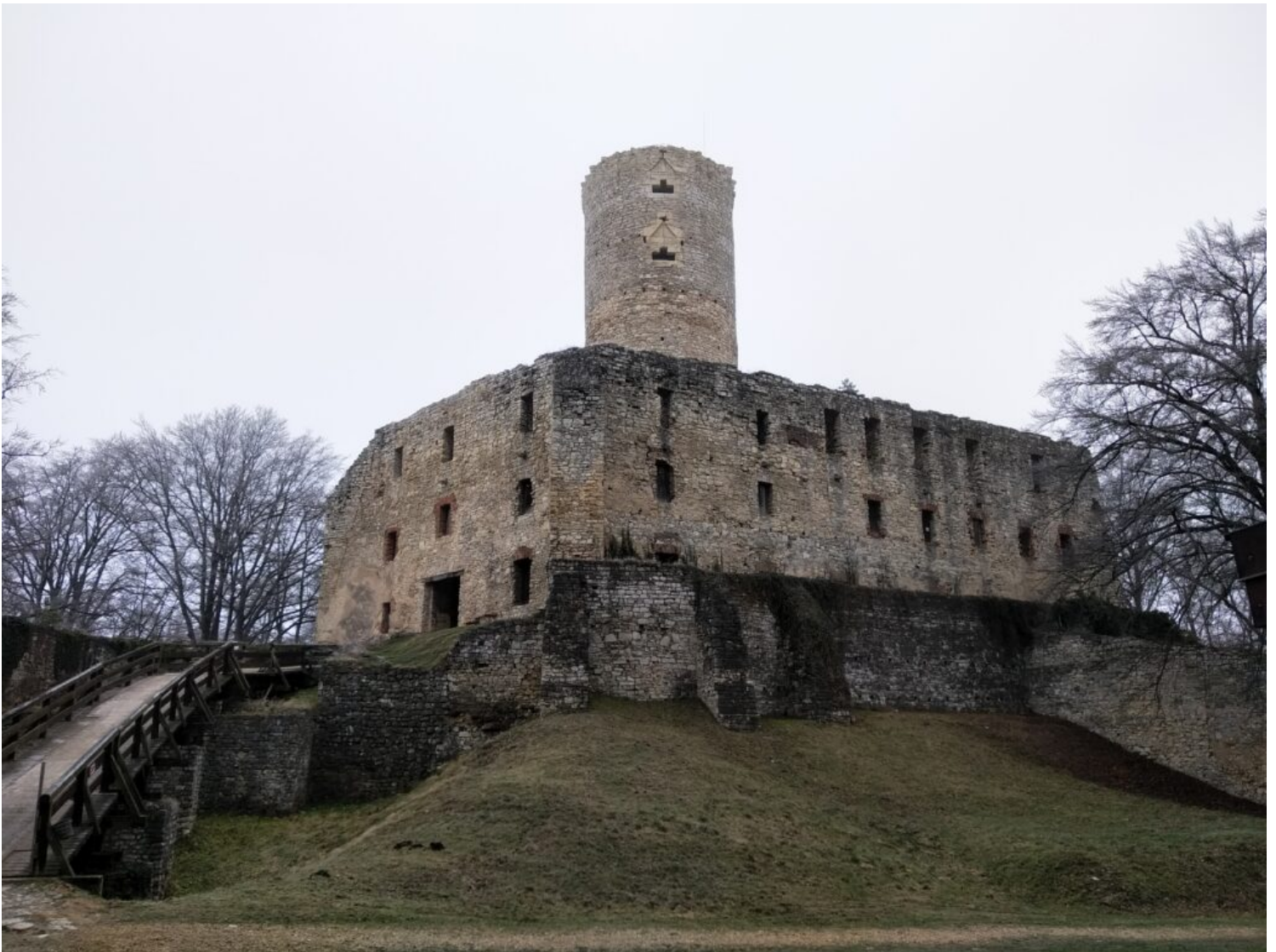
(obiekt przed) fot. Archiwum MMZ w Wygielzowie
