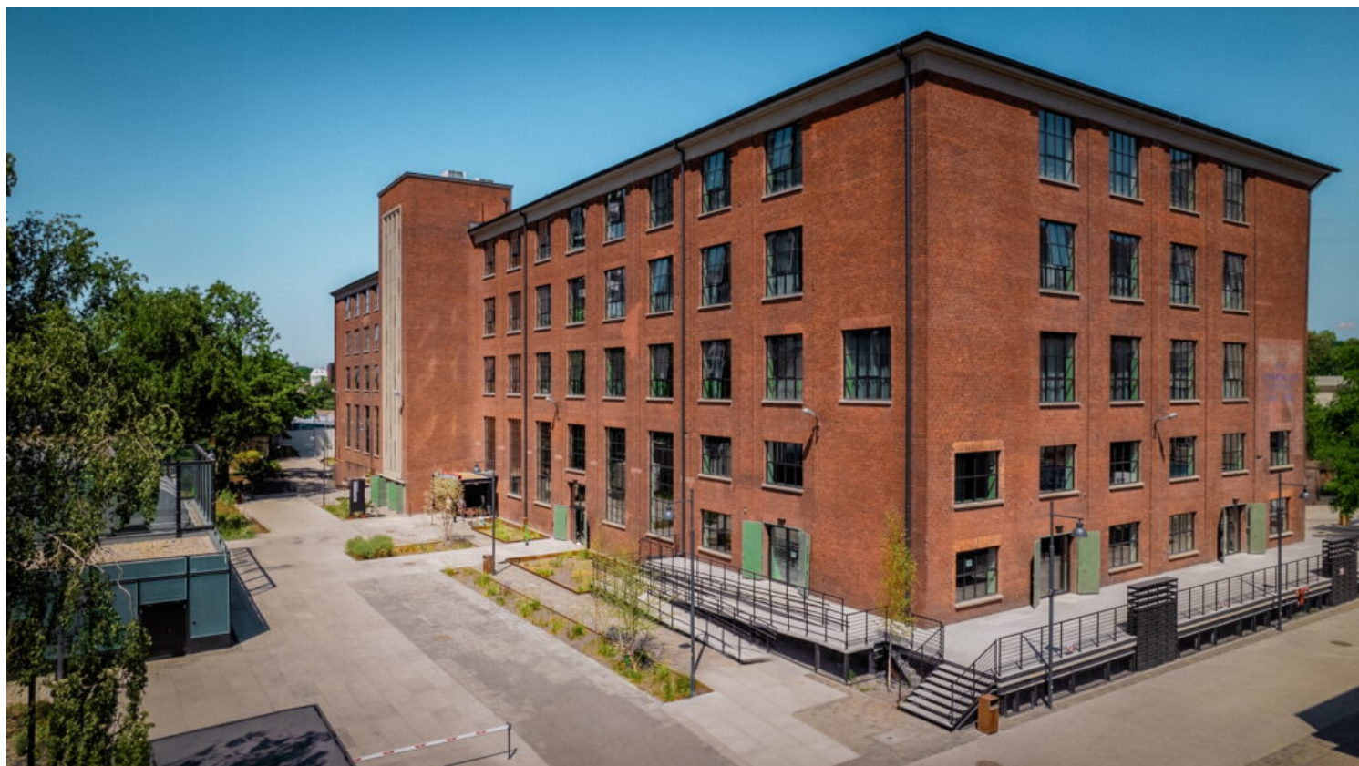
(obiekt po) fot. Archiwum Euro Styl S.A.
