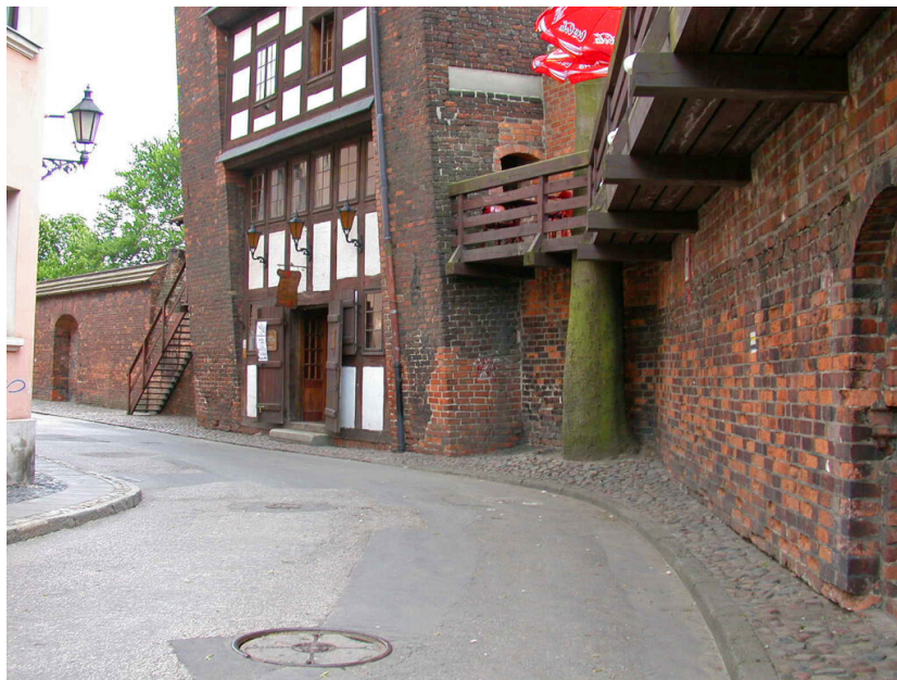
Stan w 2020 roku - nawierzchnię stanowił – w większej części – bruk przełożony z kamieni polnych (wykonany z oryginalnego materiału, jedynie przełożonego na czas remontu), nawiązując w ten sposób do historycznych nawierzchni ulic biegnących pod murami miasta, fot. NID/ Robert Kola
