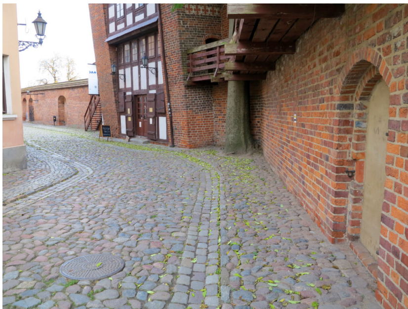
Toruń, ul. Pod Krzywą Wieżą. Ulica o nawierzchni brukowanej z końca XIX wieku, później przykrytej asfaltem, z jednostronnym, wąskim chodnikiem, stan na 2003 rok, fot. NID/ Robert Kola
