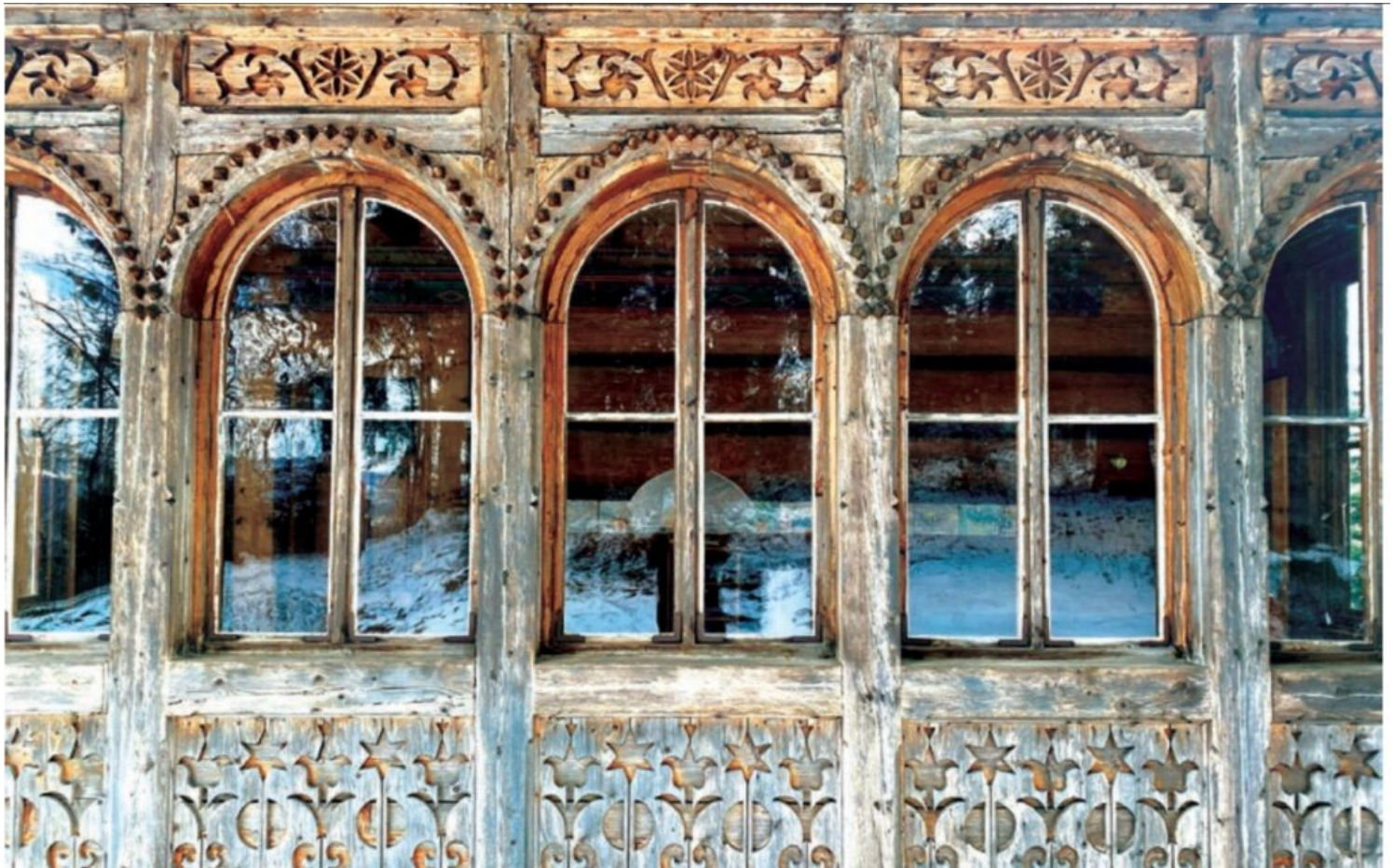
Zakopane, dom Pod Jedlami. Zaprojektowana specjalnie na potrzeby tego konkretnego budynku drewniana stolarka okienna równoważy rozedrgany, koronkowy snycerski detal architektoniczny przeszklonej werandy, składając się na jedyny w swoim rodzaju, niemożliwy do powtórzenia w innym materiale wyraz artystyczny Witkiewiczowskiej willi w stylu zakopiańskim. Fot. NID/N. Skiepmo, 2023
