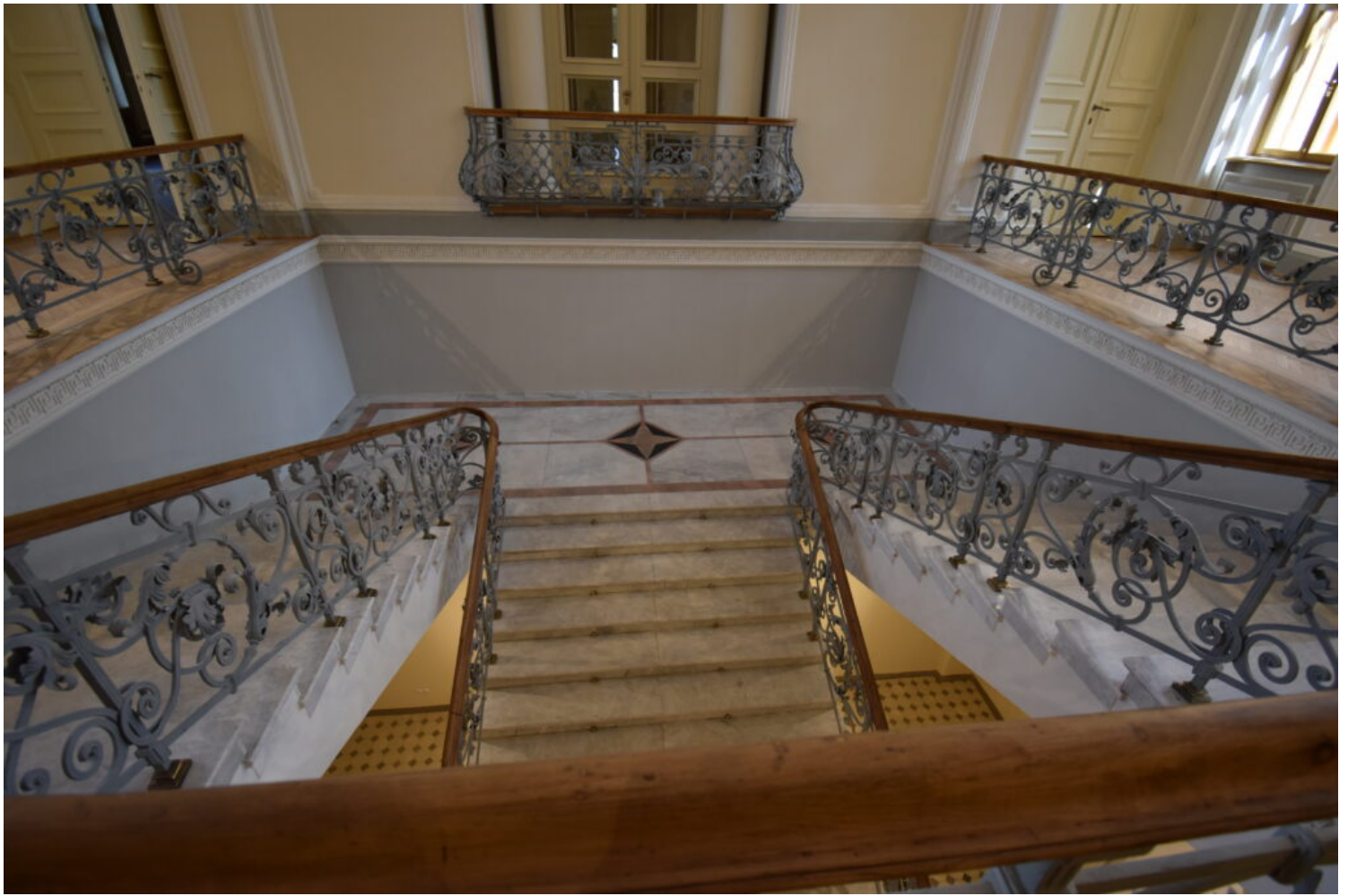
Kategoria utrwalenia wartości zabytkowej obiektu, laureat Miasto Nowy Dwór Mazowiecki, fot. Miasto Nowy Dwór Mazowiecki
