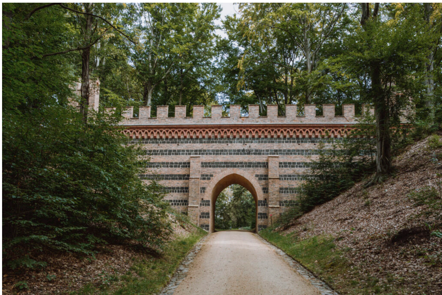
Wiadukt, fot. Maciej Jabłoński, F11
