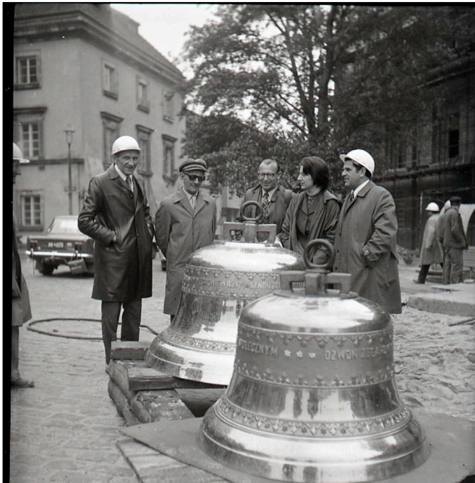
Montaż dzwonów lipiec 1974 fot. M. Samborski
