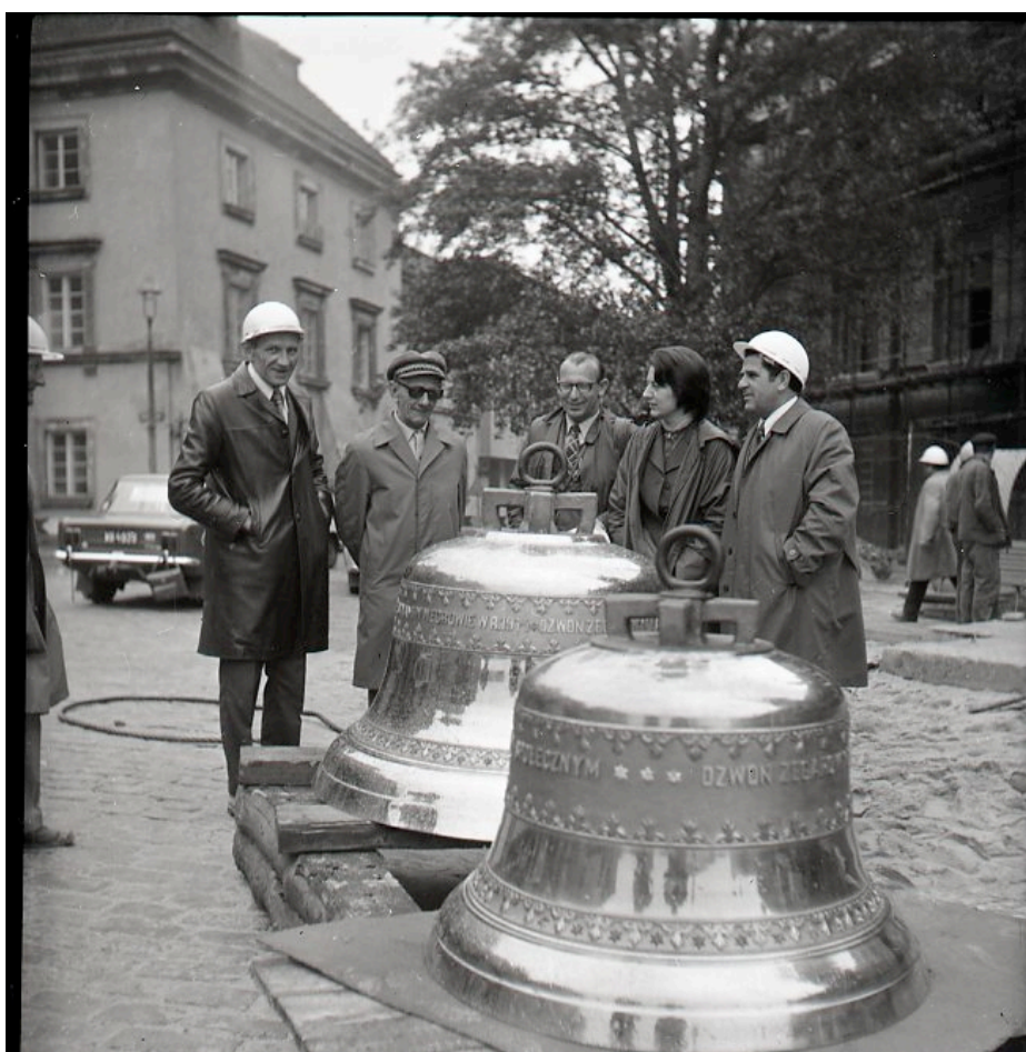
Montaż dzwonów lipiec 1974 fot. M. Samborski
