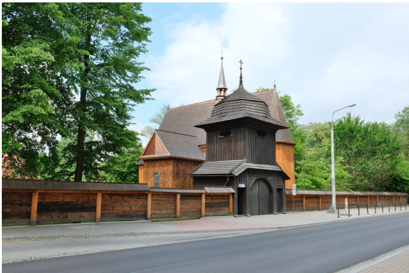
Kraków, Mogiła, kościół pw. św. Bartłomieja Apostoła i dzwonnica bramna z 1752 r, stan z 2022 r., fot. NID/A. Hanaka
