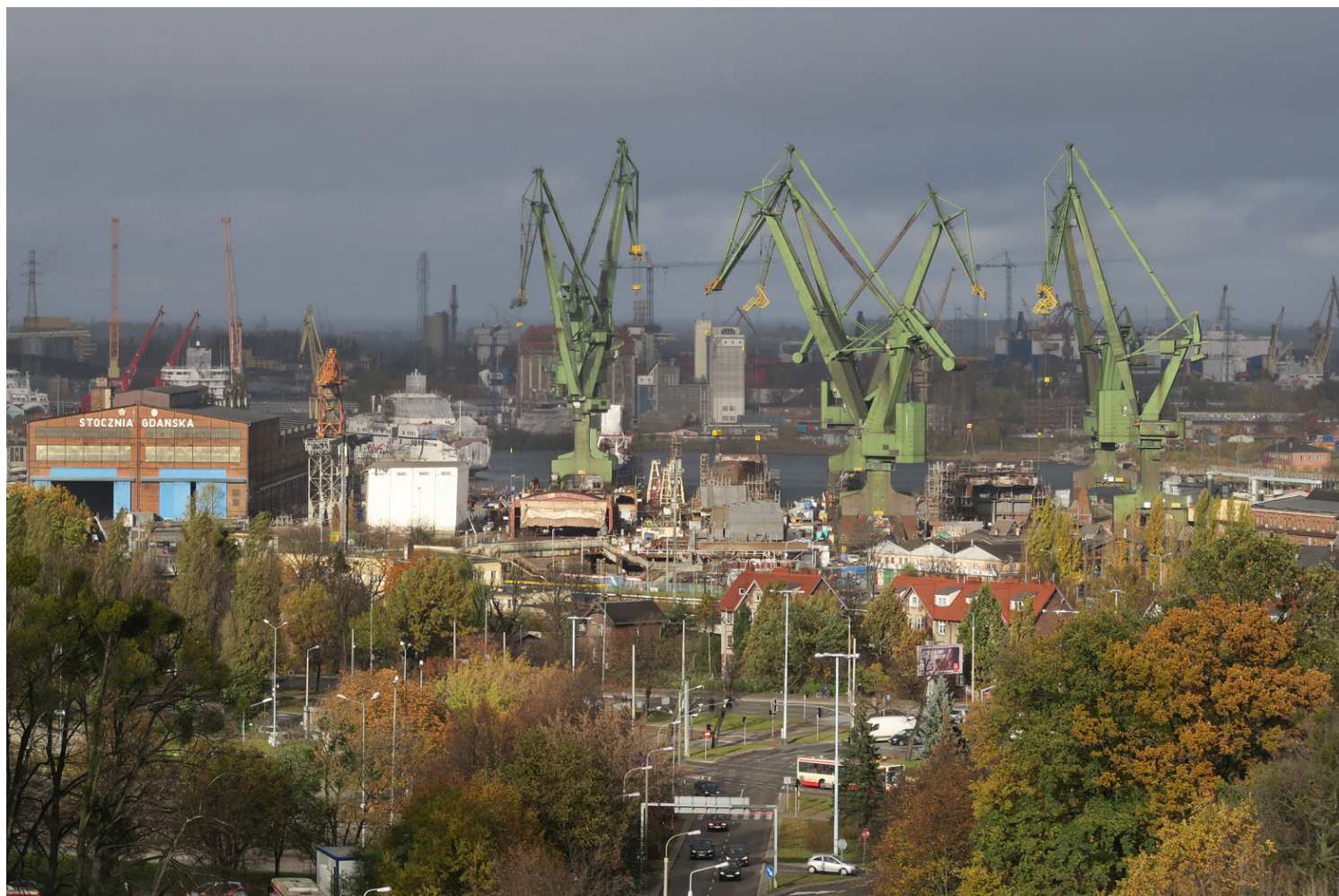
Gdańskie żurawie portowe Fot. Tomasz Błyskosz
